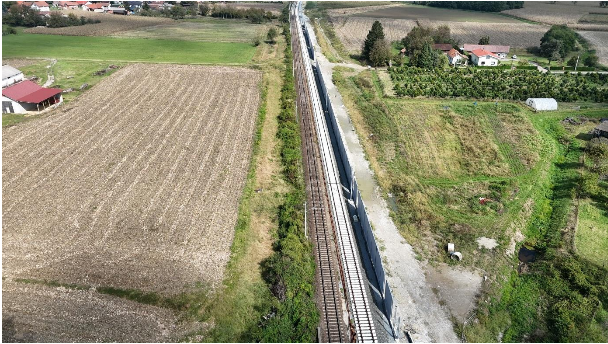
Slika 18. Novoizgrađeni kolosijek (desno) i postojeći nerekonstruirani (lijevo) kolosijek
