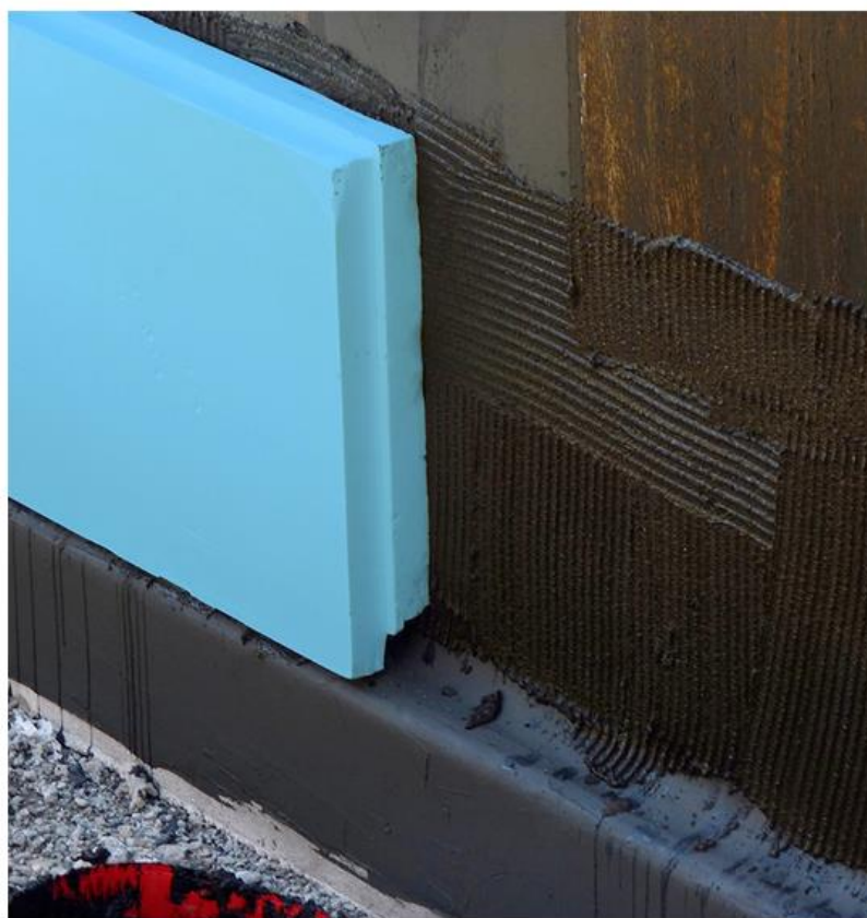
Slika 10. Izolacija vanjskih zidova XPS-om [12]
