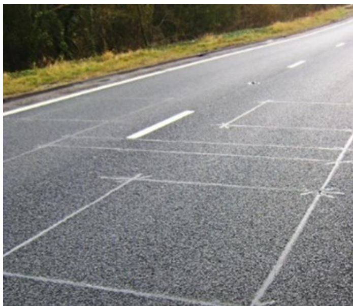
Slika 15 Senzori ugrađeni u cestu mjere prolaz svakog vozila
