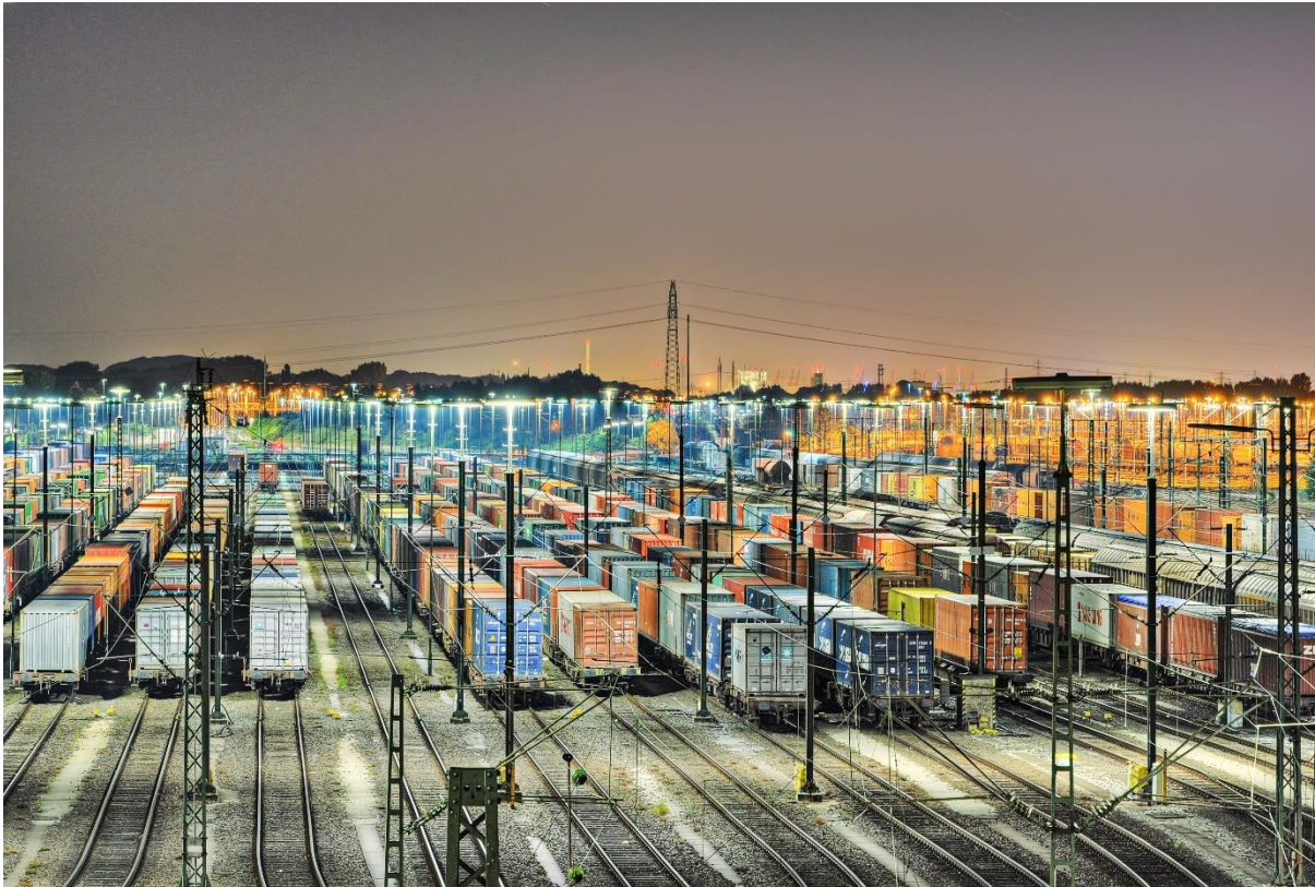
Slika 11 - Dio terminala Ostrava-Paskov u Češkoj Republici
