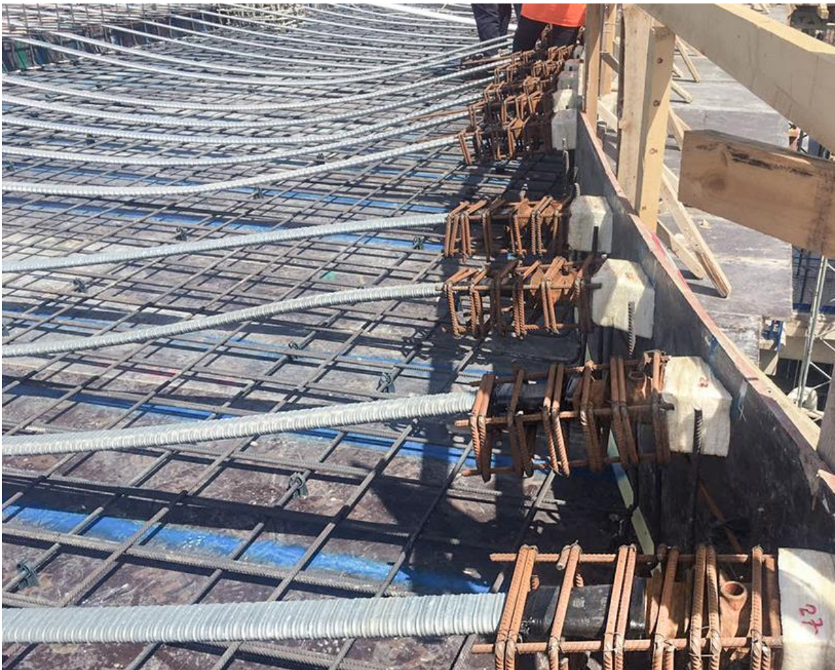
Slika 2.3 Prikaz „bonded“ kabela za naknadno prednapinjanje (Izvor: [7])
