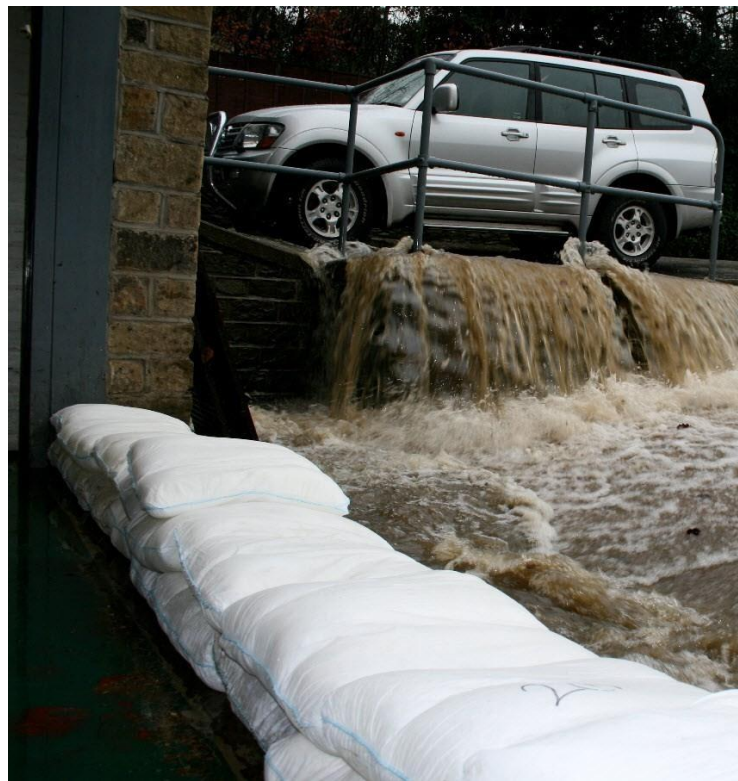
Slika 15: Vreće s pijeskom kao obrana od poplava [15]
