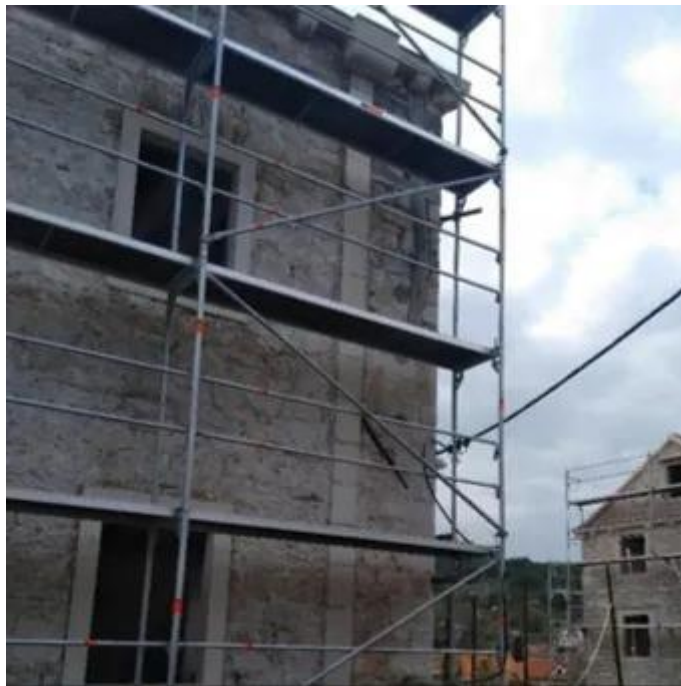
Slika 83. Ojačanje na zadnjoj etaži
