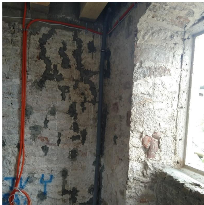
Slika 89. Injektiranje zida
