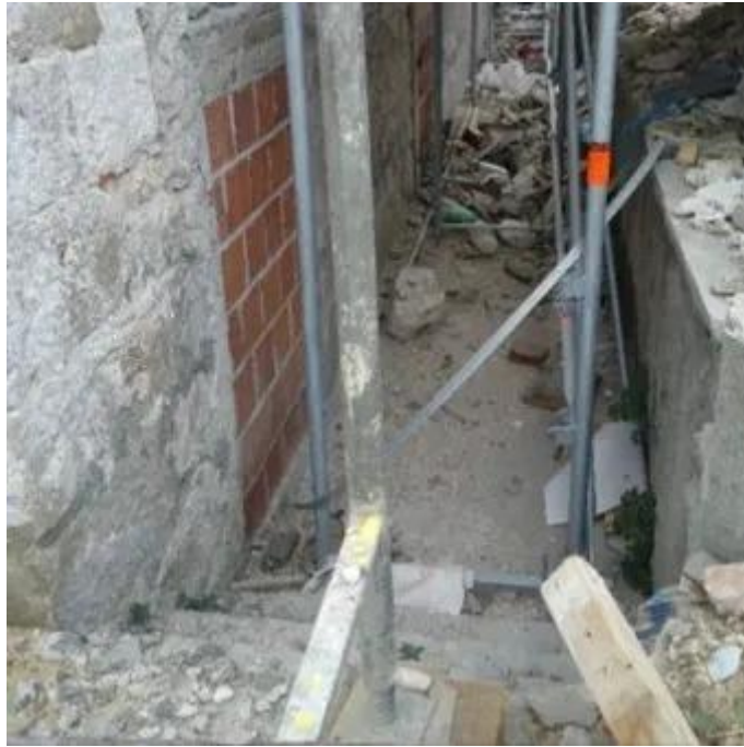
Slika 86. Zazidavanje starih otvora
