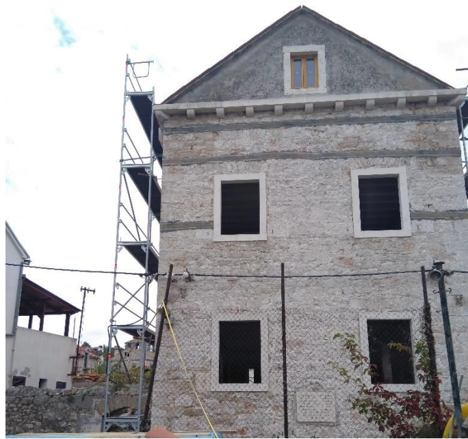
Slika 88. Spregnuti zidovi na gornjim etažama
