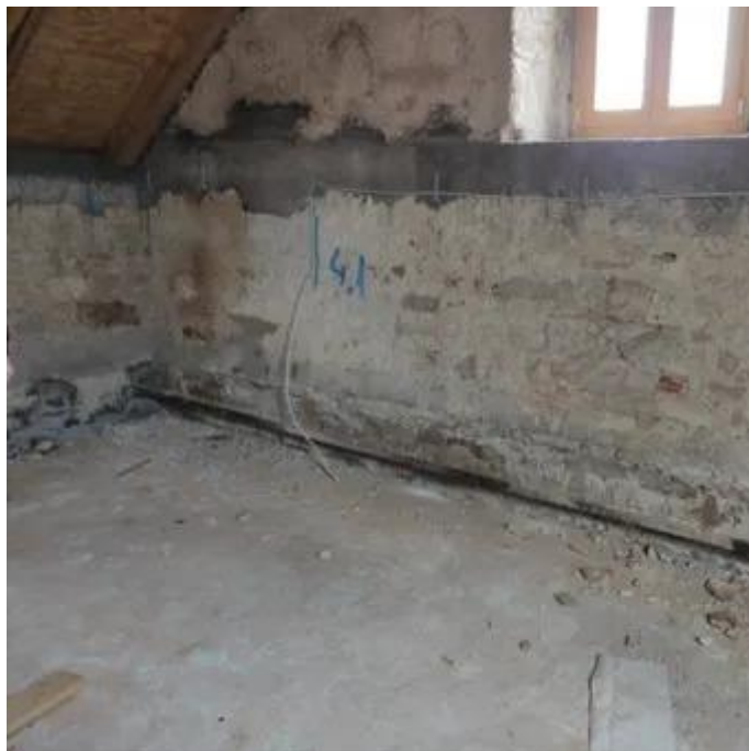
Slika 91. Betoniran zid atike
