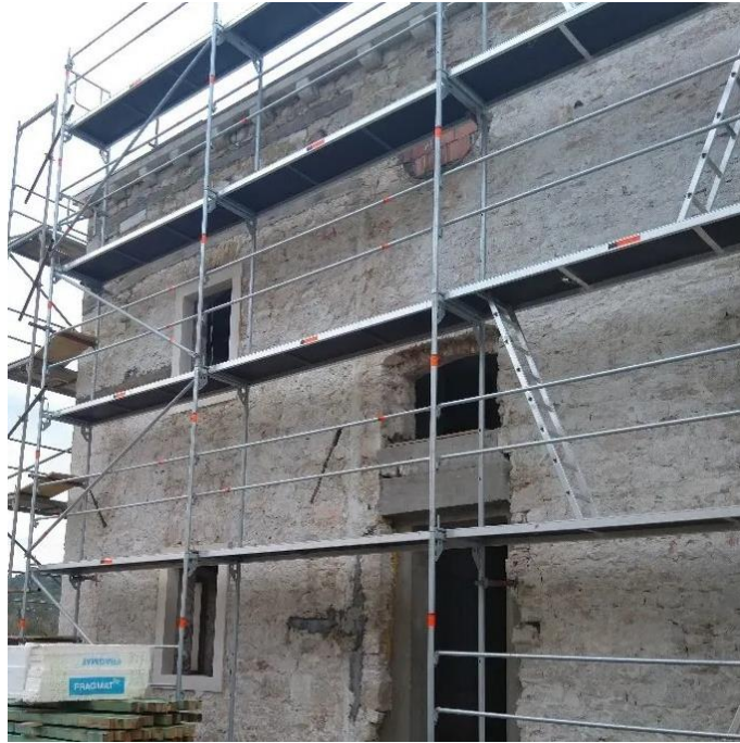
Slika 82. Uklonjeno vanjsko stubište
