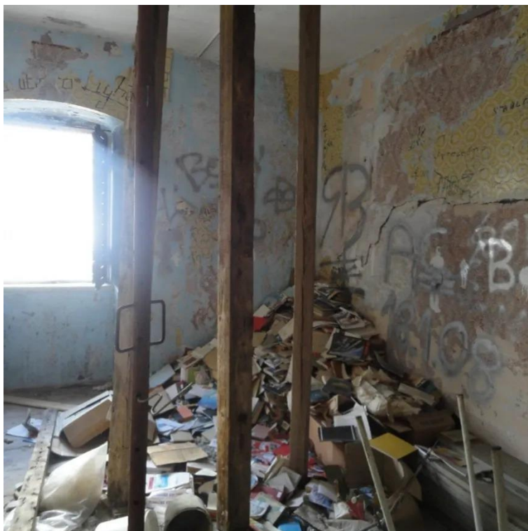
Slika 16. Prostorija na prvom katu s pogledom na sjever
