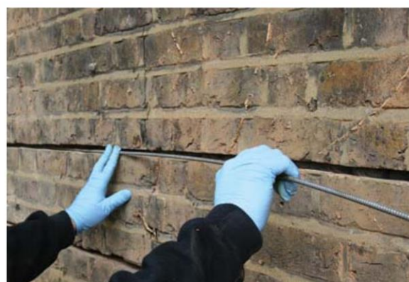
Slika 66. Postava čeličnih šipki u nove fuge
