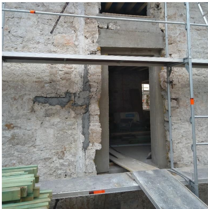
Slika 87. Ojačanje otvora
