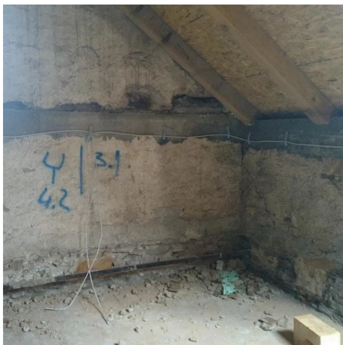
Slika 76. Ojačanje zidova atike
