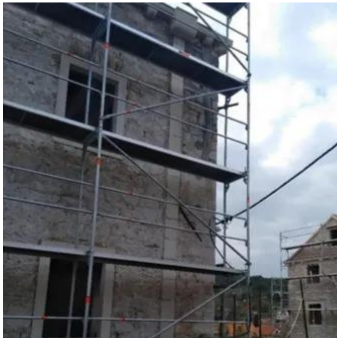
Slika 83. Ojačanje na zadnjoj etaži
