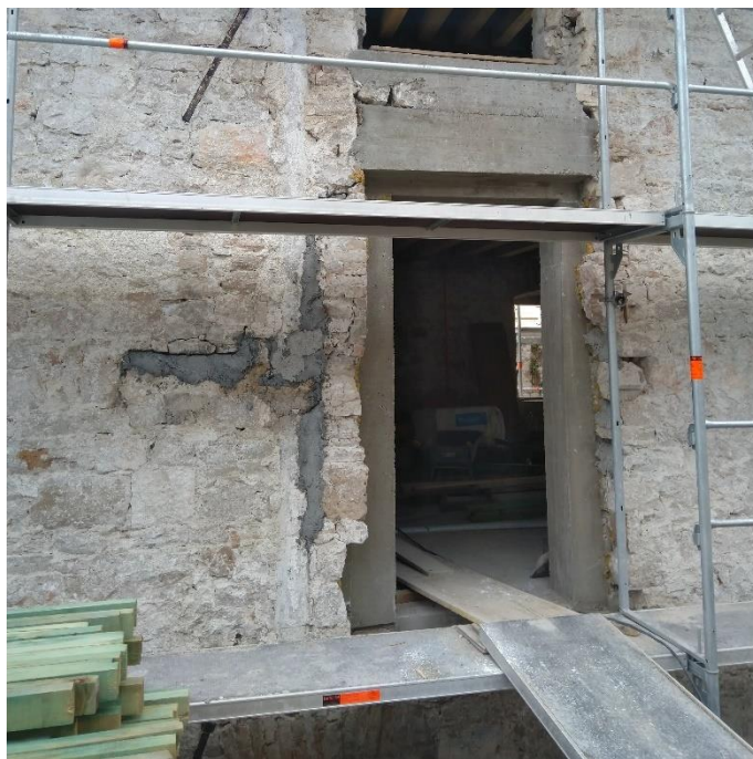
Slika 87. Ojačanje otvora
