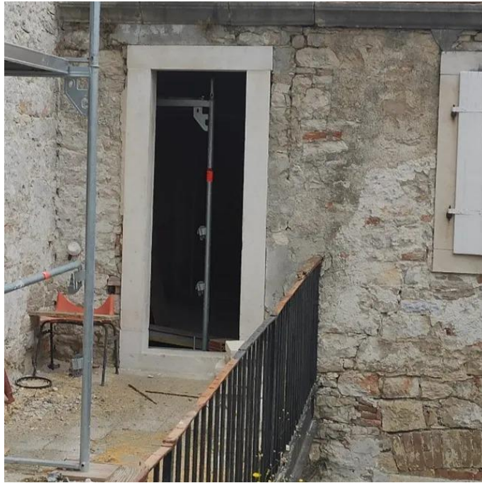
Slika 90. Početak sanacije otvora
