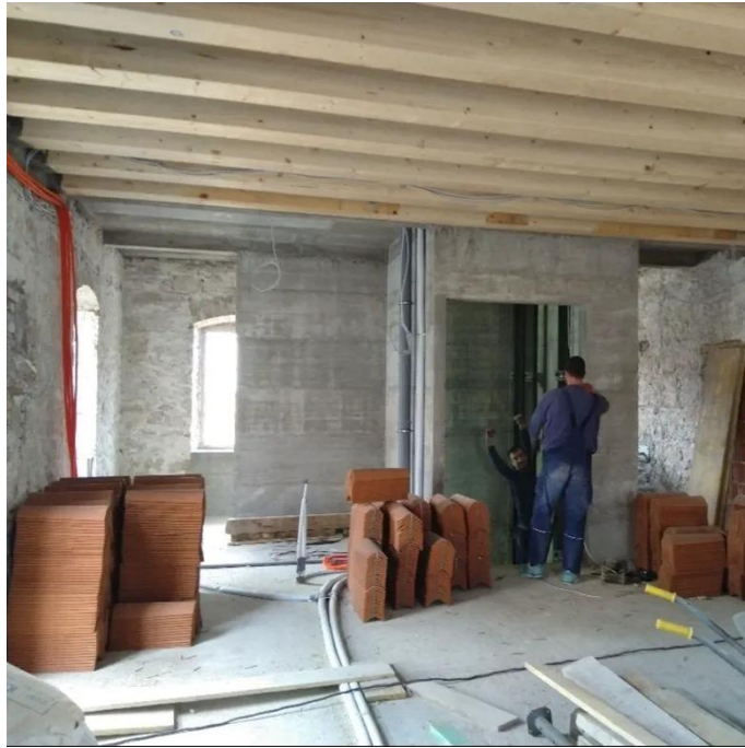
Slika 72. Novougrađeno okno lifta
