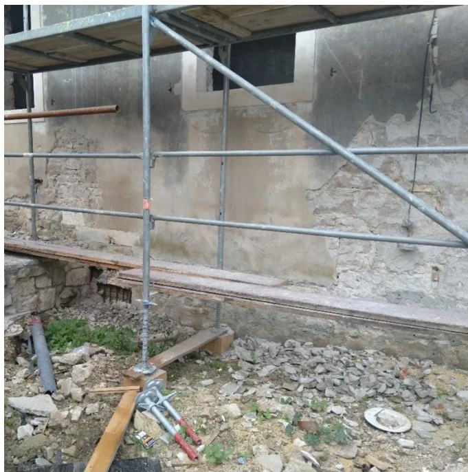
Slika 85. Početak postave skele
