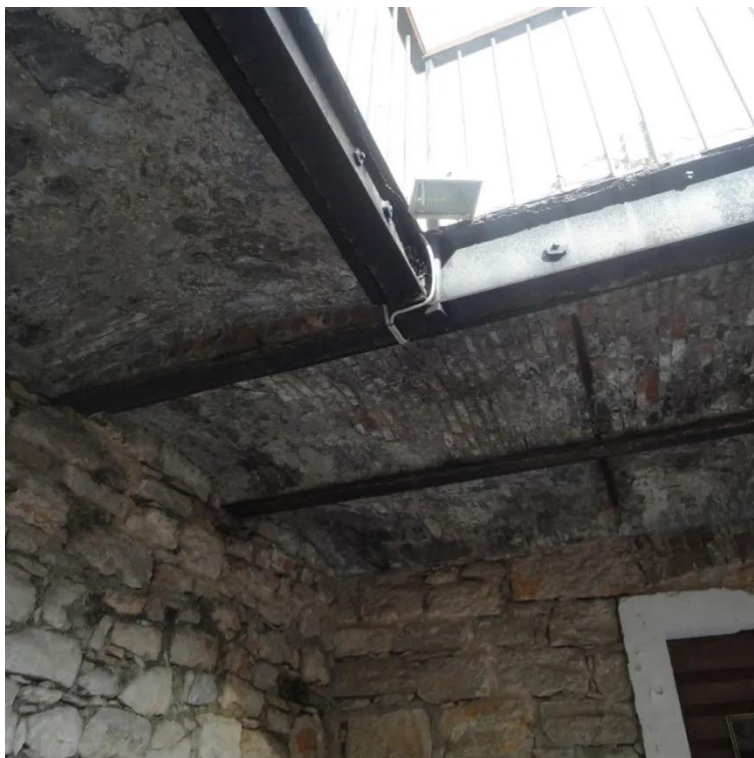
Slika 12. Pogled iz atrija na terasu
