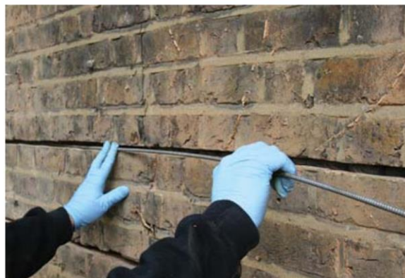
Slika 66. Postava čeličnih šipki u nove fuge
