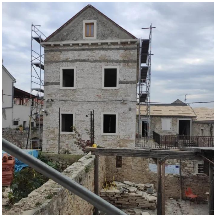
Slika 94. Uklonjena stara fasada
