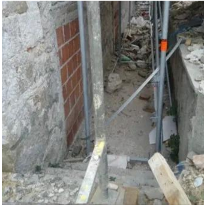
Slika 86. Zazidavanje starih otvora
