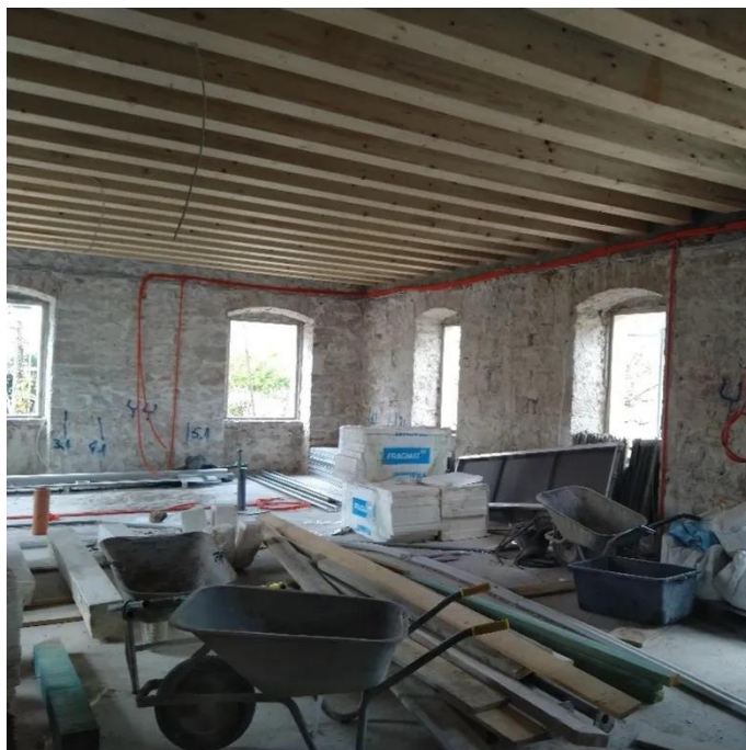
Slika 71. Prikaz novog drvenog gredniika
