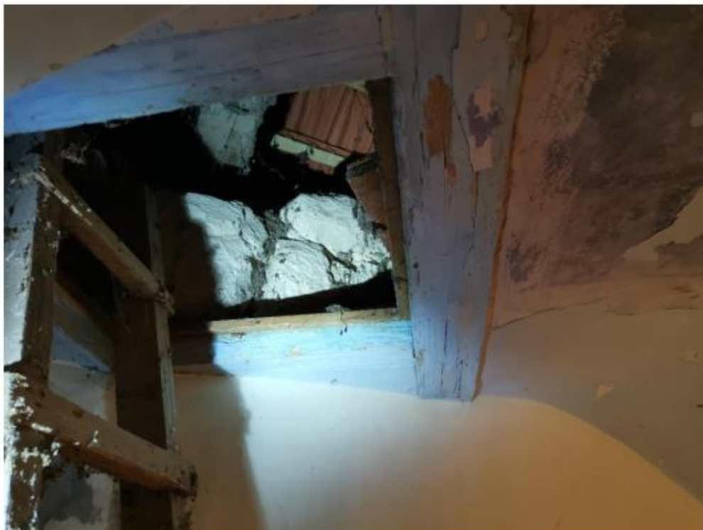
SLIKA ULAZA U PROSTOR KROVIŠTA
