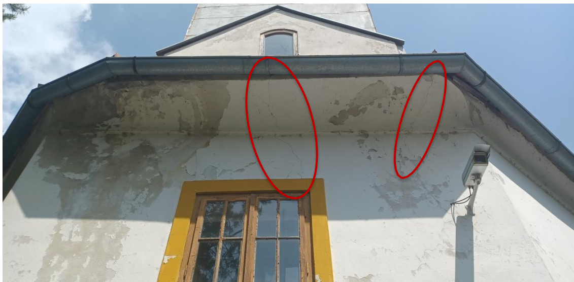
Slika 31: Krovni vijenac na zapadnom pročelju
