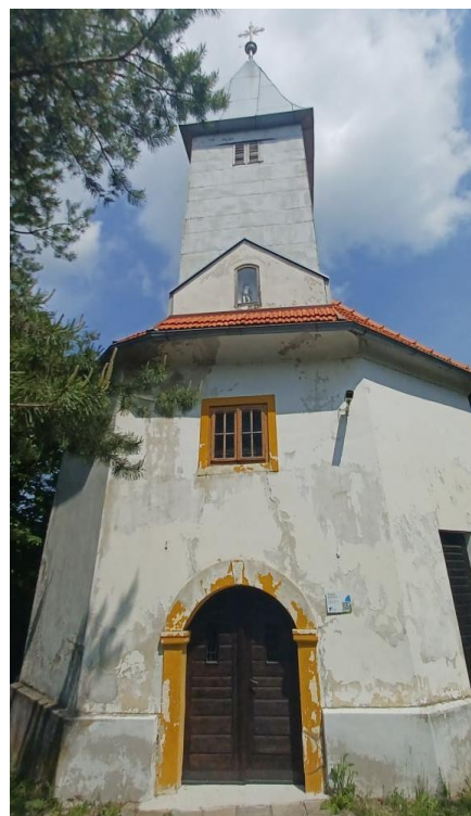
Slika 29: Sjeverno (lijevo) i zapadno (desno) pročelje
