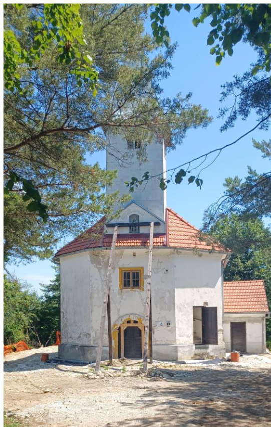
Slika 14: Ulaz na stepenice koje vode na pjevalište – kor (lijevo) i pročelje s privremenom mjerom ojačanja zvonika (desno)
