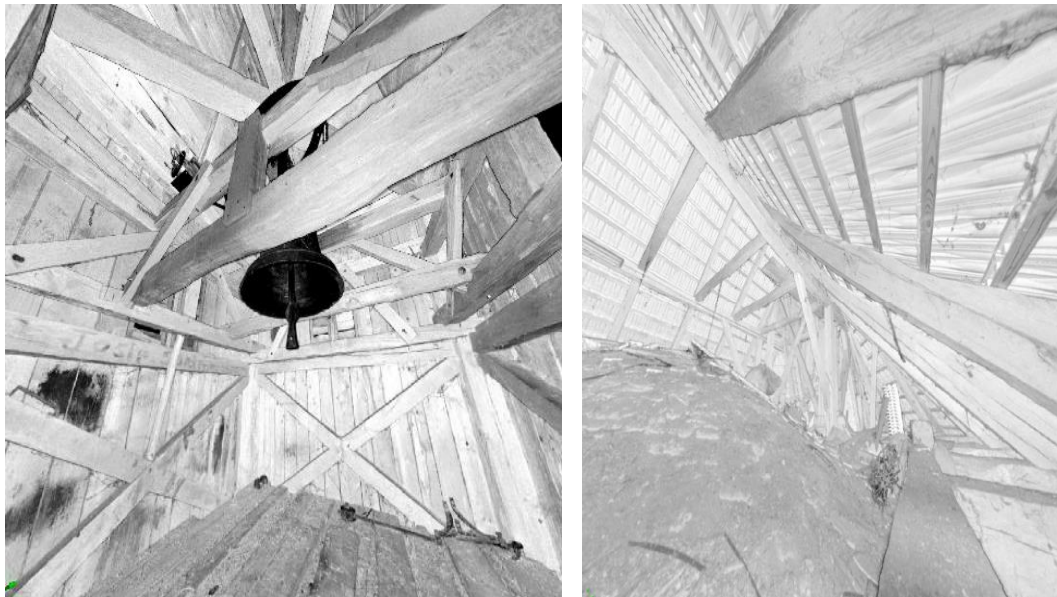
Slika 13: Krovište – zvonik (lijevo) i brod (desno)
