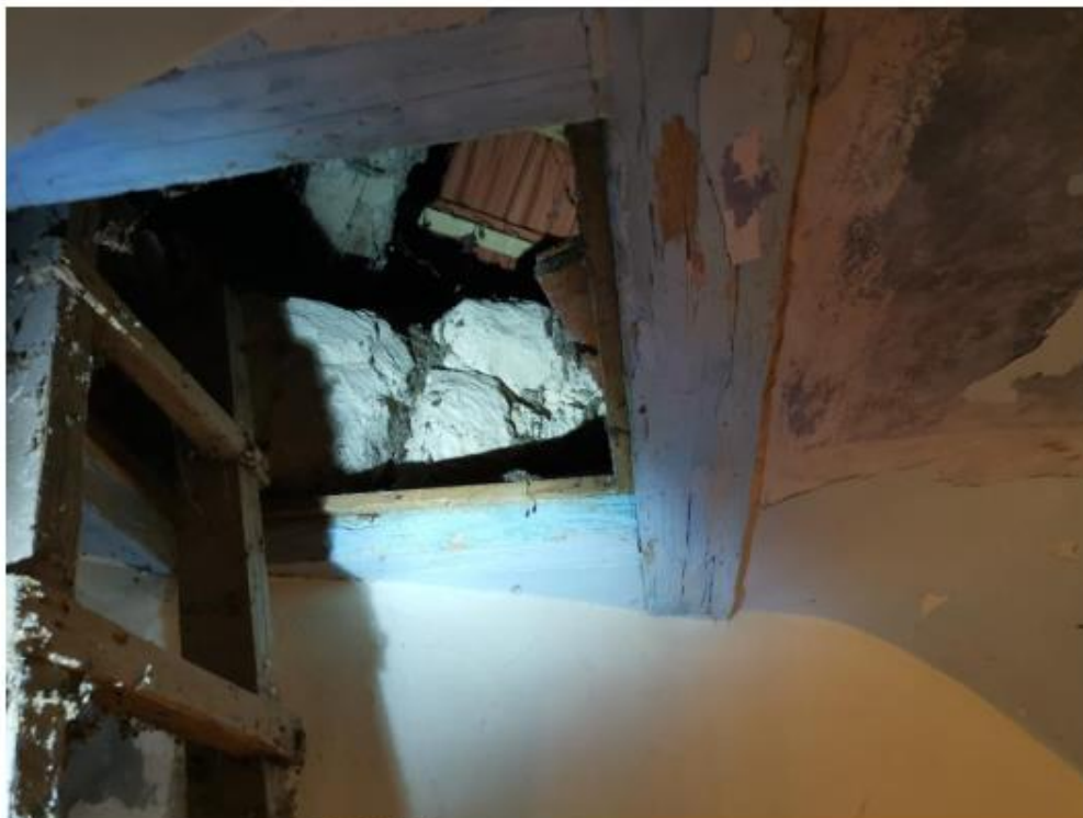
SLIKA ULAZA U PROSTOR KROVIŠTA
