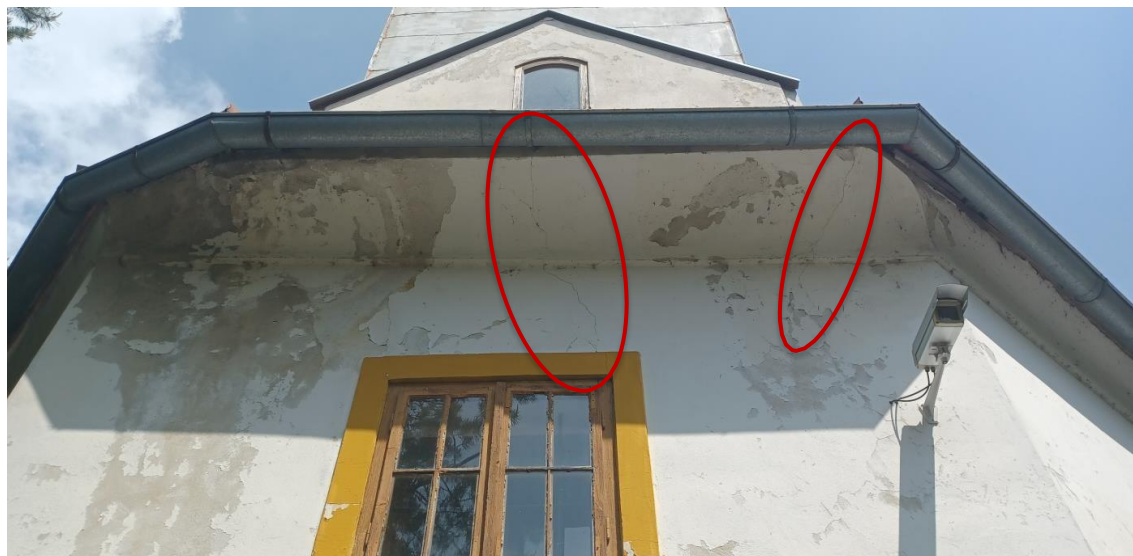
Slika 31: Krovni vijenac na zapadnom pročelju
