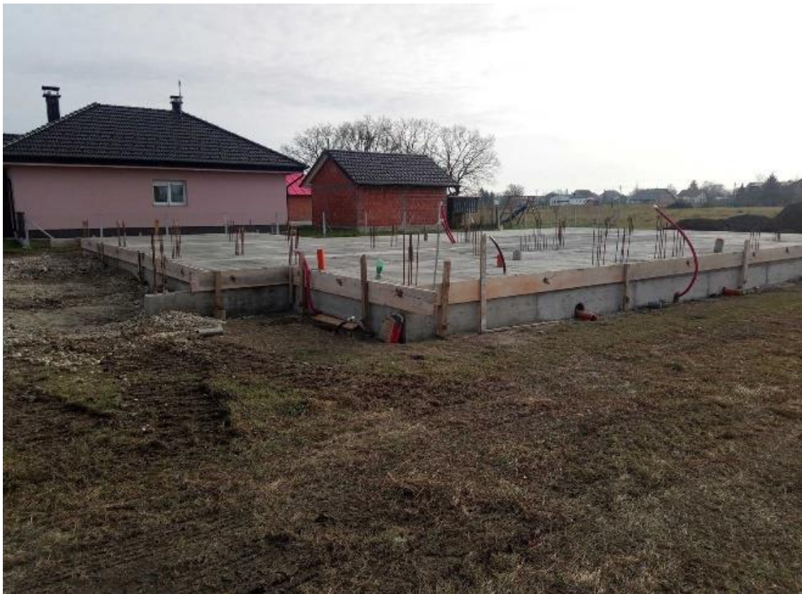
Slika 3.3.1 Betoniranje nadtemeljnih serklaža i AB podne ploče
