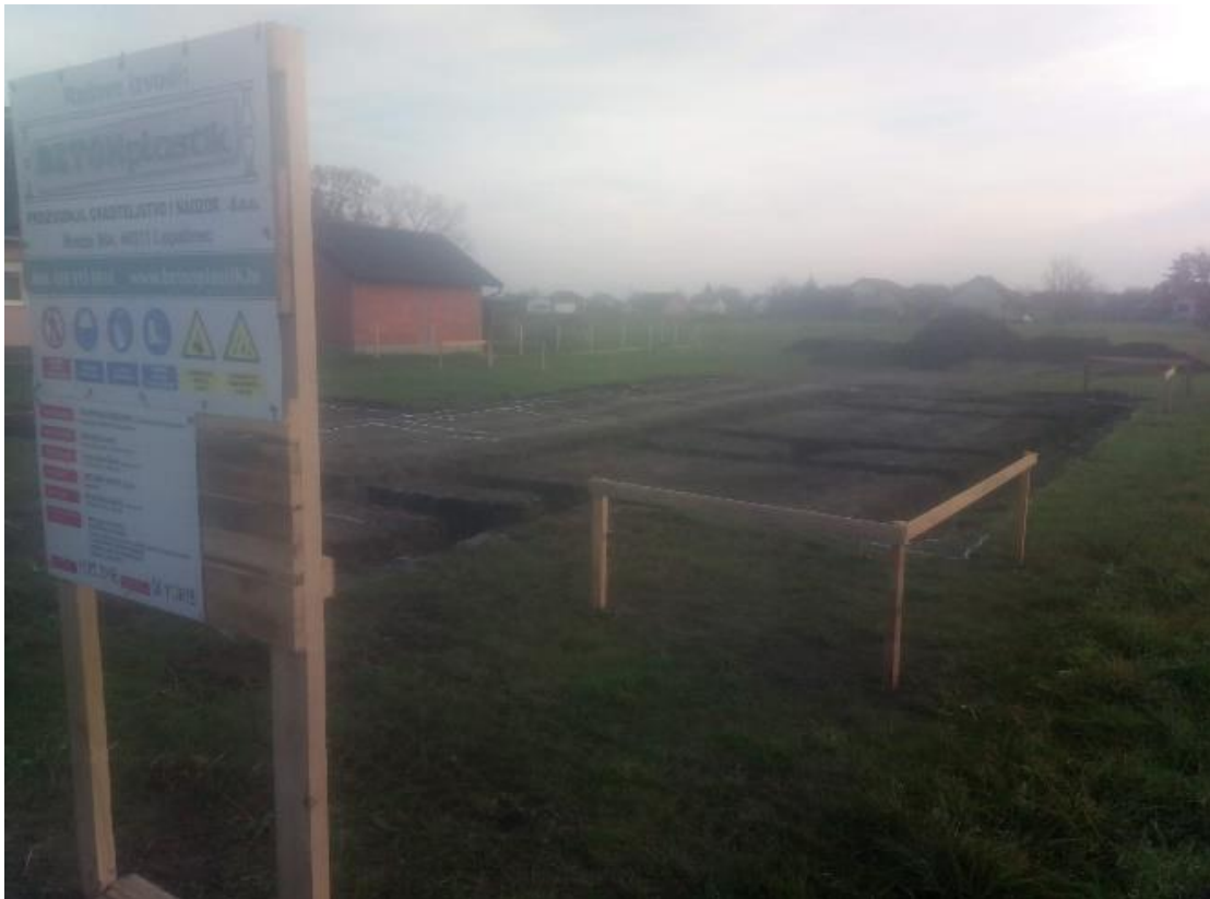
Slika 3.1.1. Iskopane temeljne trake
