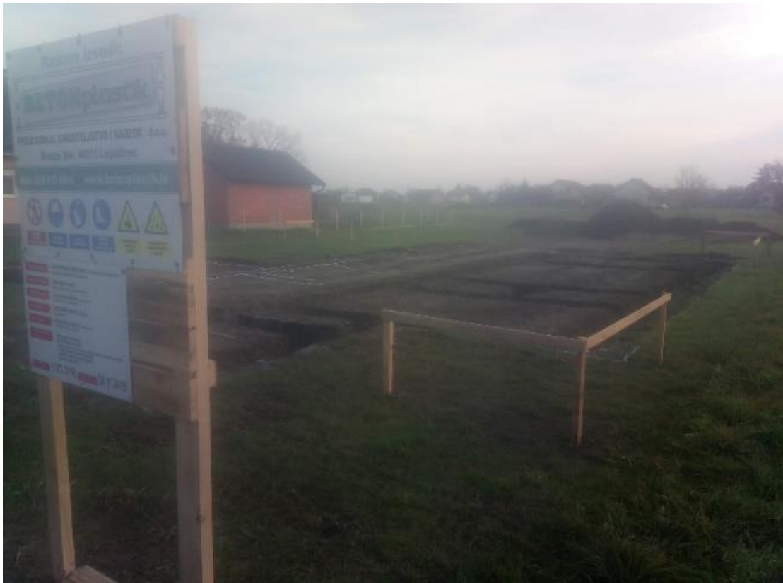
Slika 3.1.1. Iskopane temeljne trake
