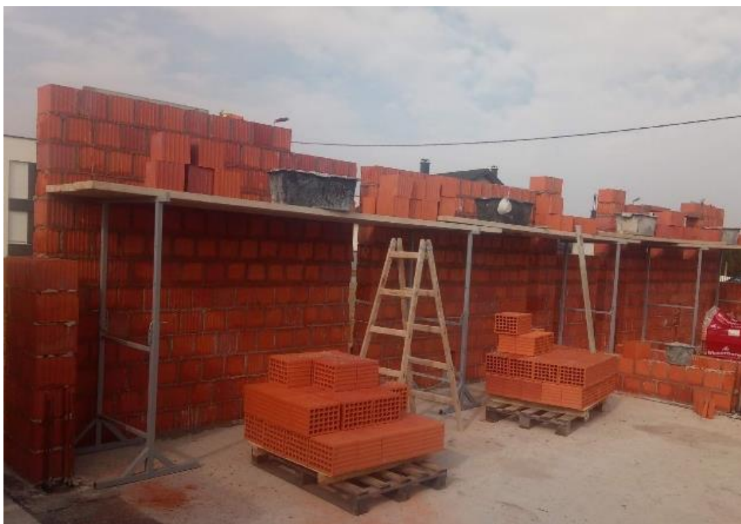
Slika 3.4.1. Zidanje nosivih zidova
