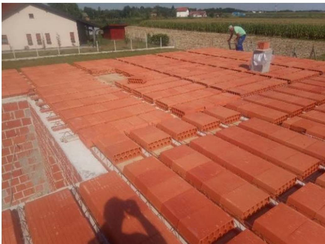
Slika 3.4.2. FERT strop
