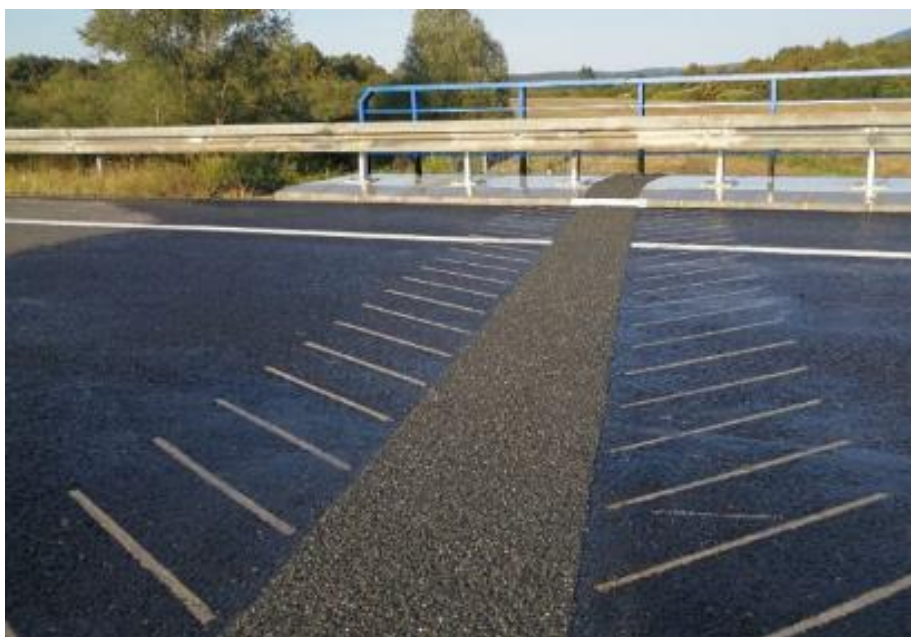
Slika 18 Bitumenska kontinuirana prijelazna naprava, [4]
