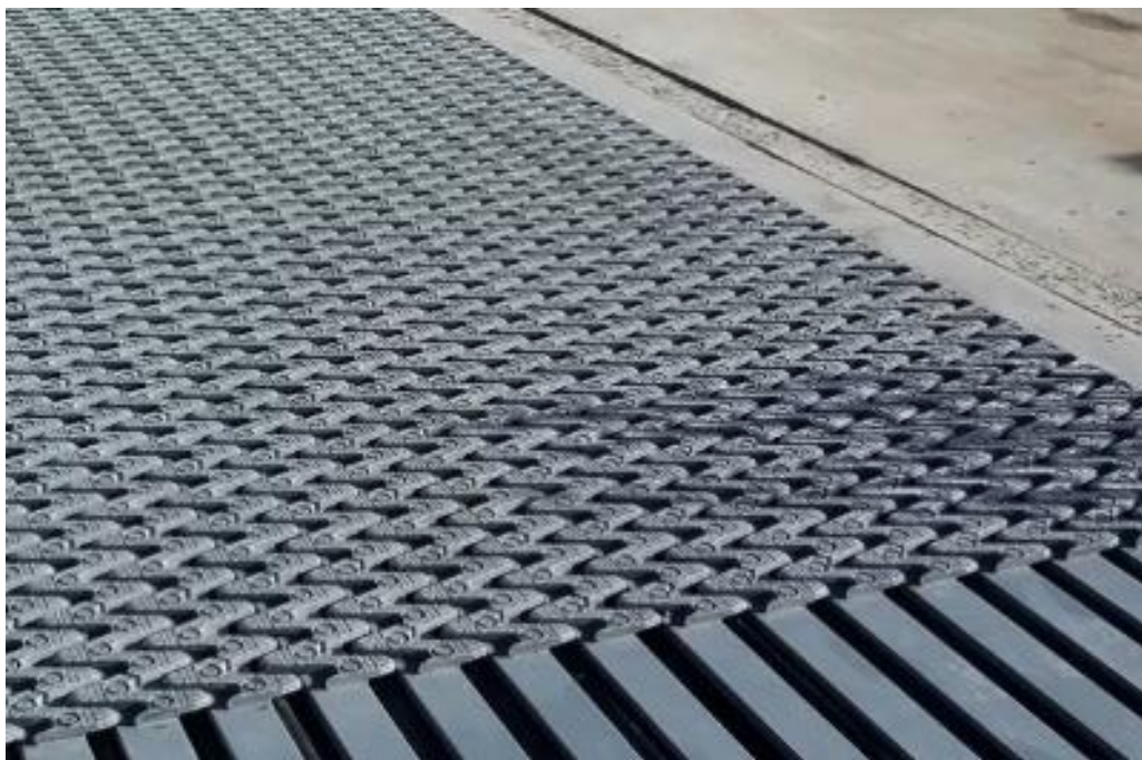
Slika 29 Modularna prijelazna naprava, [4]
