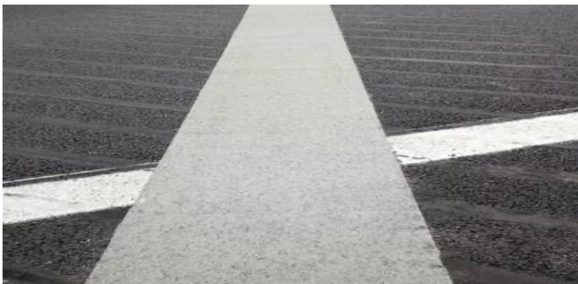
Slika 20 Poliuretanska kontinuirana prijelazna naprava, [4]
