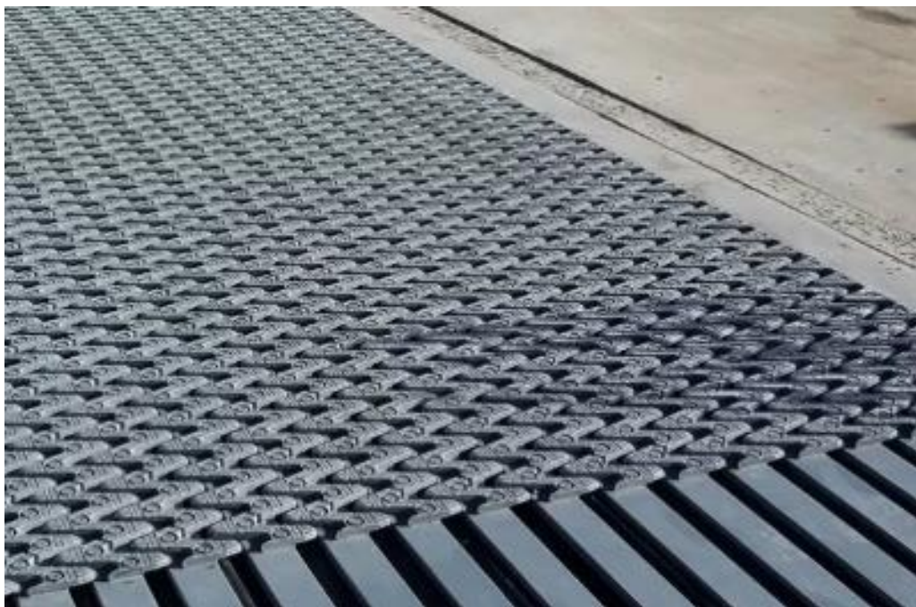
Slika 29 Modularna prijelazna naprava, [4]
