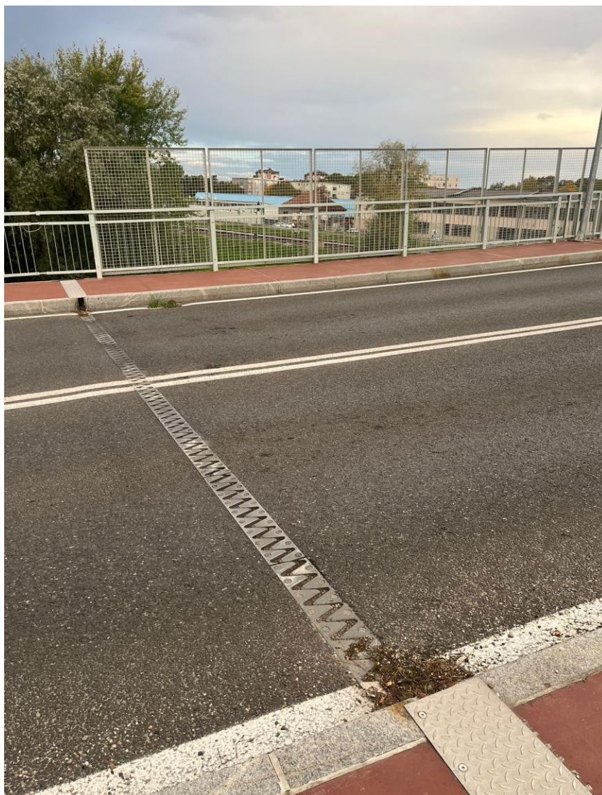
Slika 31 Jednoprofilna prijelazna naprava na nadvožnjaku u Čakovcu, (10.10.2024.)
