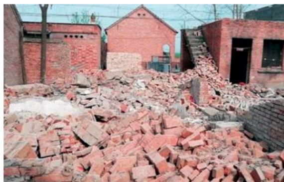
Slika 37. Otpad od glinene opeke, otpad od rušenja [15]
