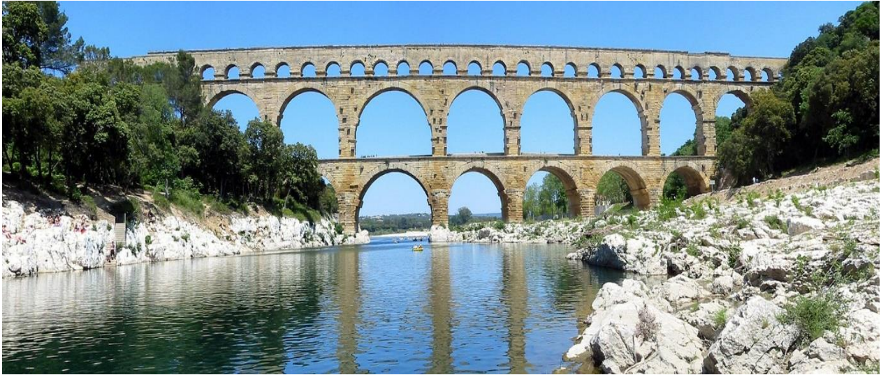
Slika 2. Most Pont du Gard [3]
