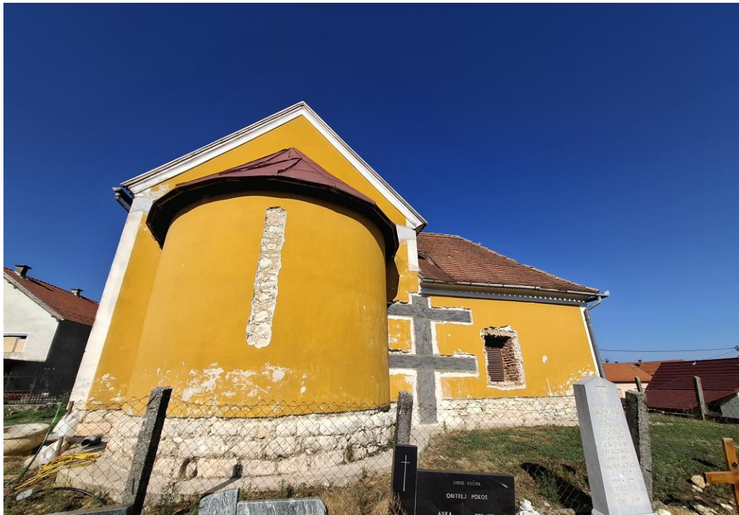
Slika 13. Prikaz istočnog pročelja
