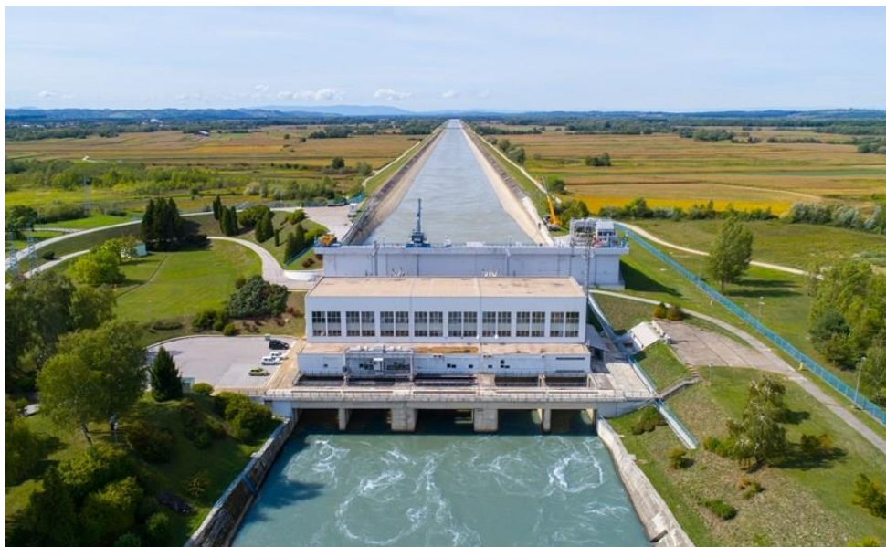
Slika 2.2 Zgrada strojarnice HE Varaždin izvana
