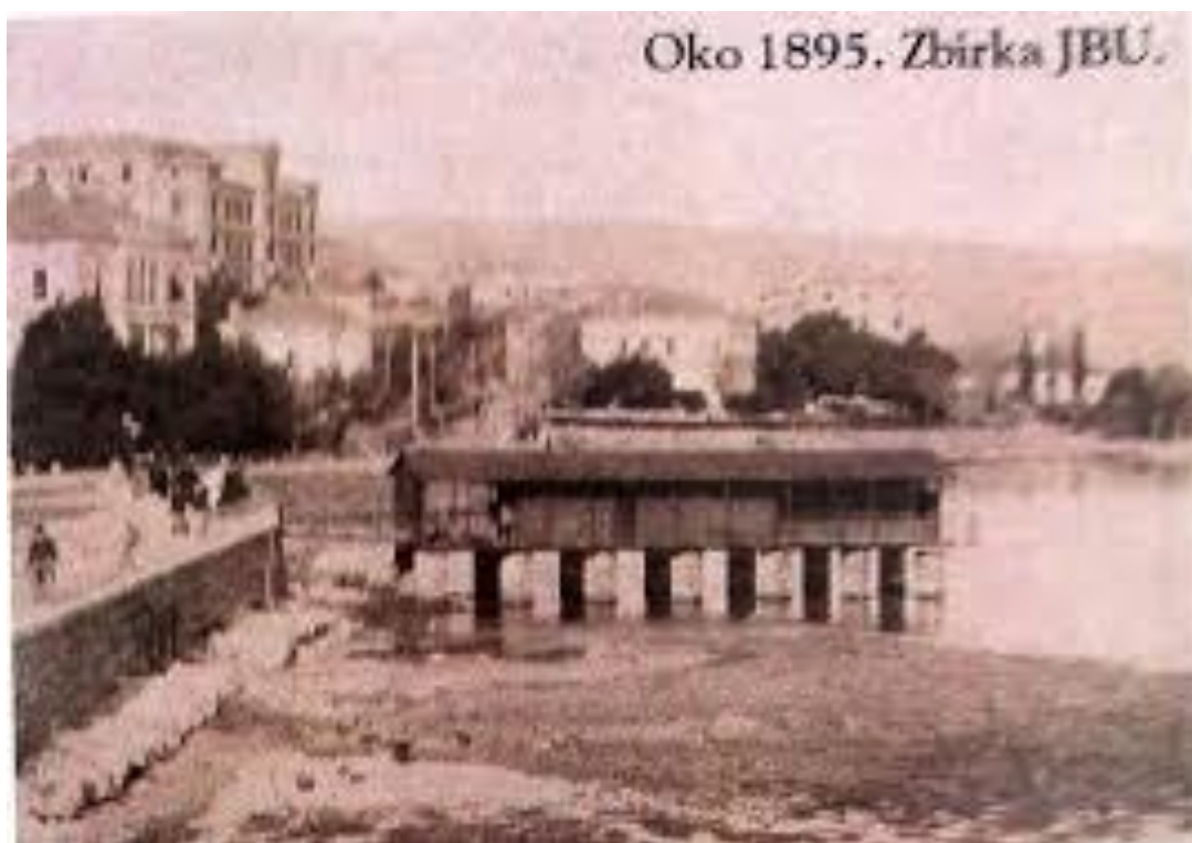
Slika 2.4.1.2. Početci izgradnje kupališta,
