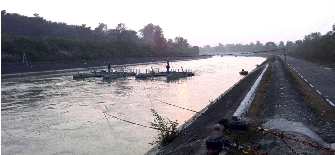
Slika 2.29 EnviroGen turbina u Chilla kanalu – Indija [23]
