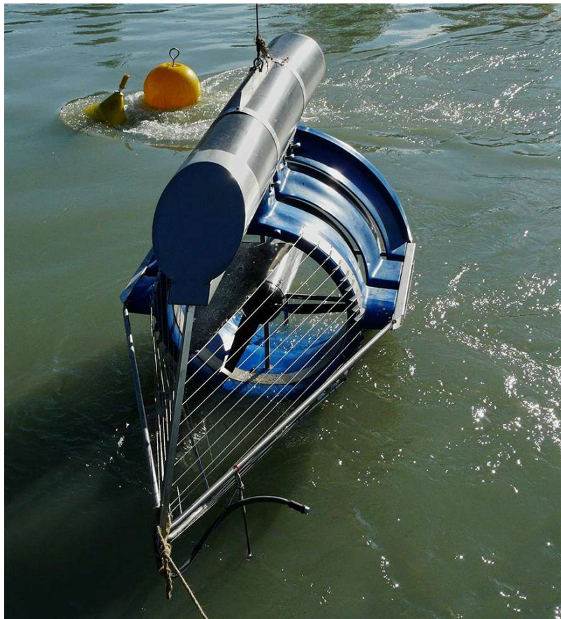
Slika 2.26 Spuštanje Smart Hydro turbine u kanal – Rosenhaim [22]
