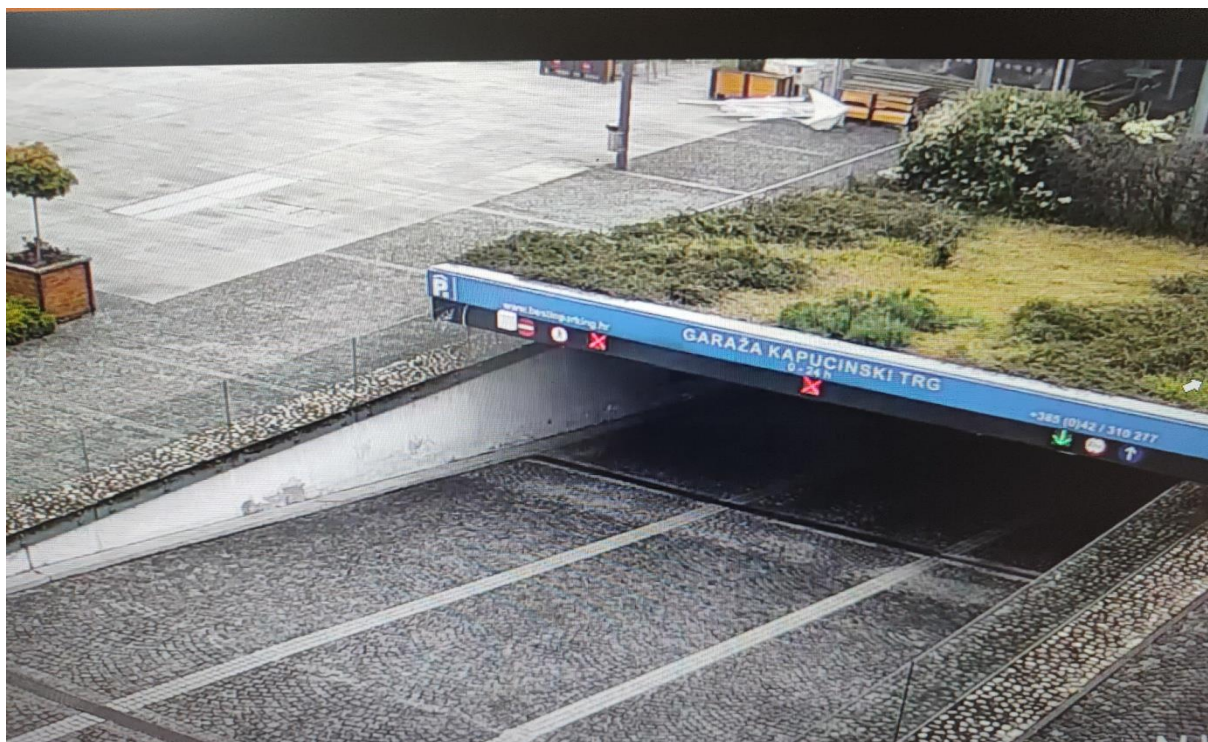
Slika 5. Podzemna garaža Kapucinski trg
