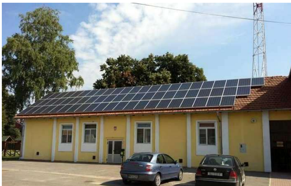
SLIKA 6.2. Fotonaponski moduli predmetne SE postavljeni na krovu okrenuti prema jugu [16]
