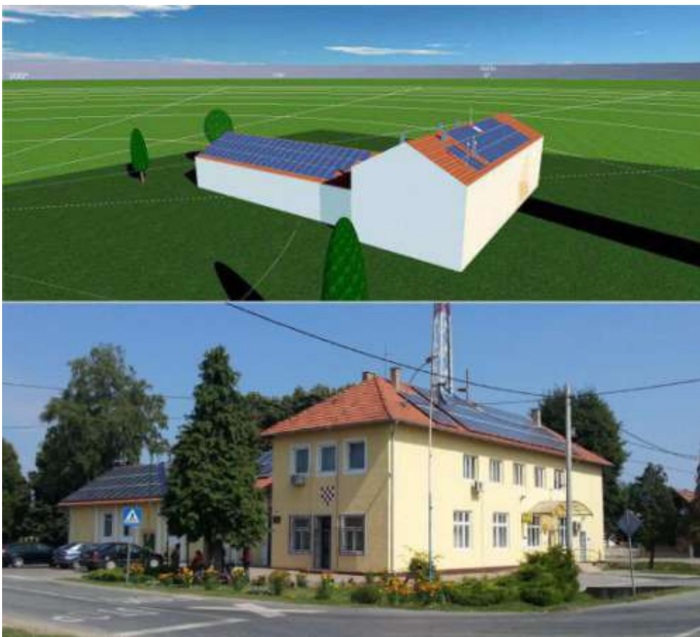
SLIKA 5.4. Prikaz predmetne SE u 3D modelu programa (gore) i stvarnom obliku (dolje)
