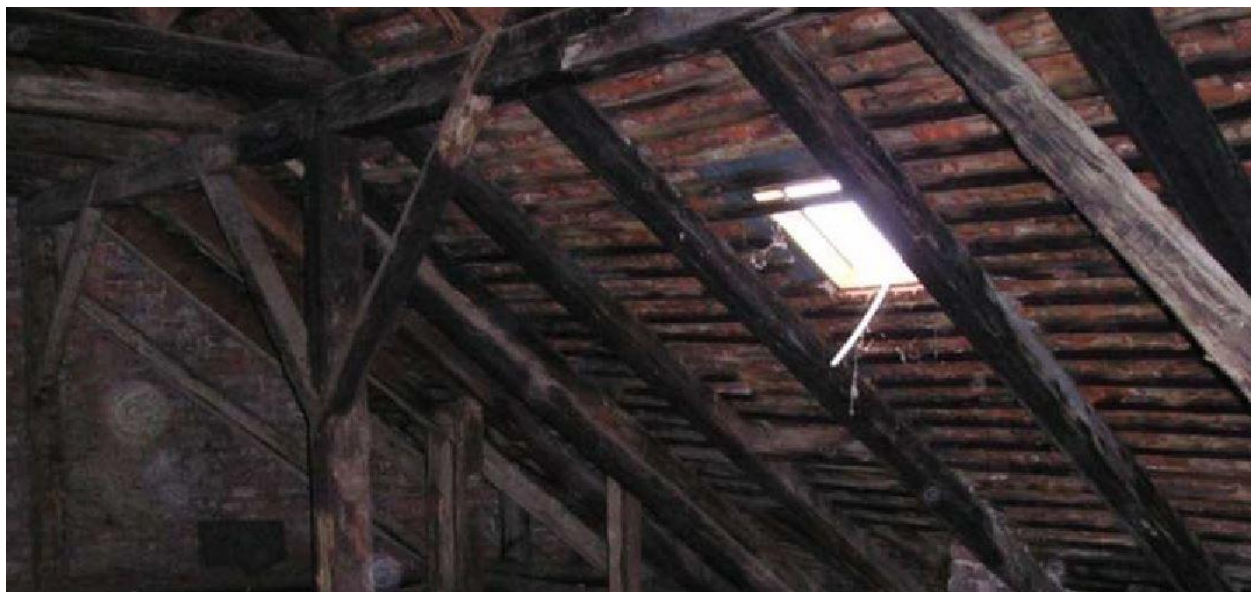
Slika 11 Postojeće stanje krovišta
