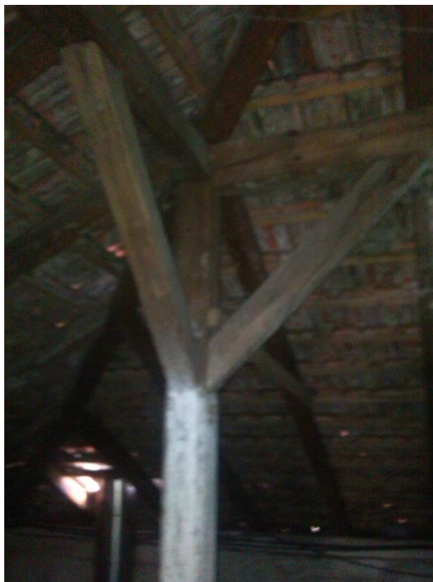
Slika 12 Detalj drvene konstrukcije postojećeg stanja
