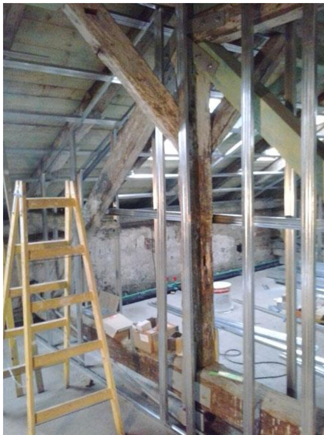
Slika 24 Postavljanje pregradnih zidova
