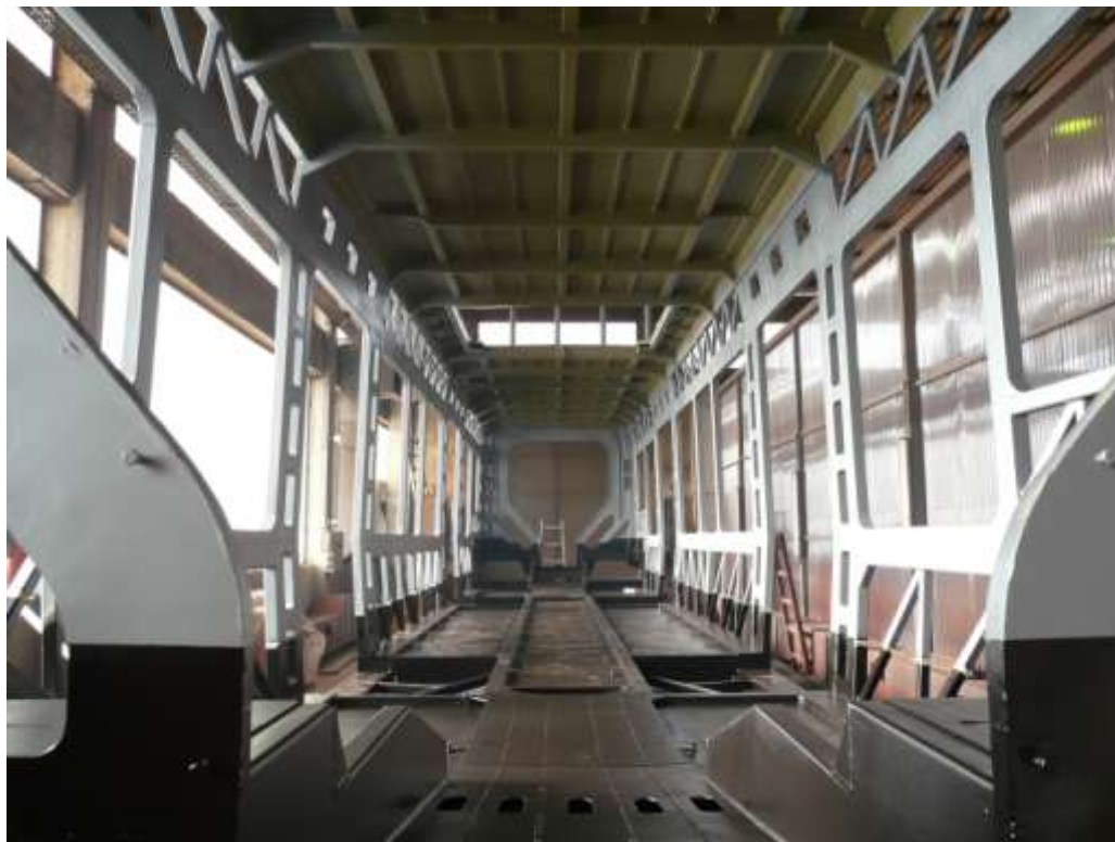
Slika 6.21 Konstrukcija krova nakon primjene AKZ
