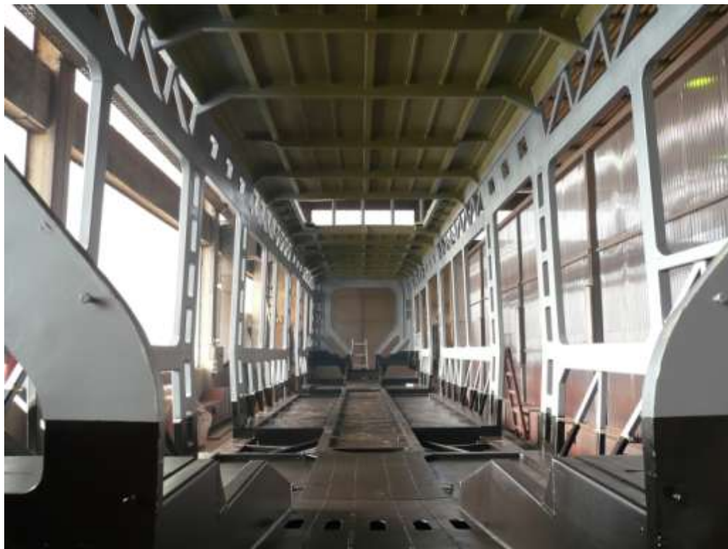
Slika 6.21 Konstrukcija krova nakon primjene AKZ
