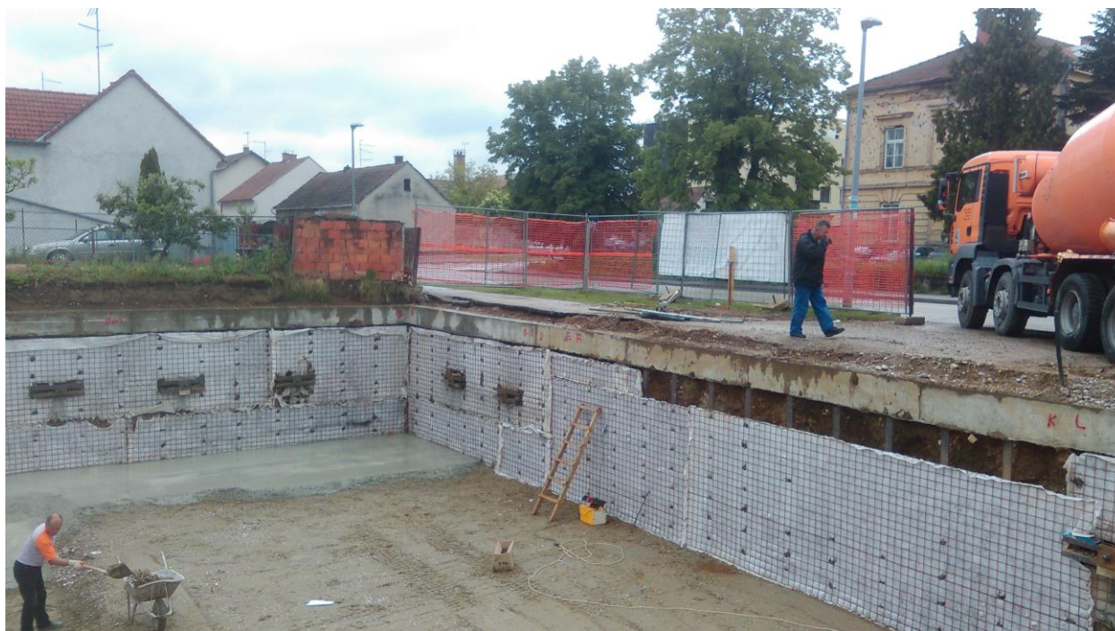
Slika 39. Presvlačenje pilotske stjenke geotekstilom i armaturnom mrežom
