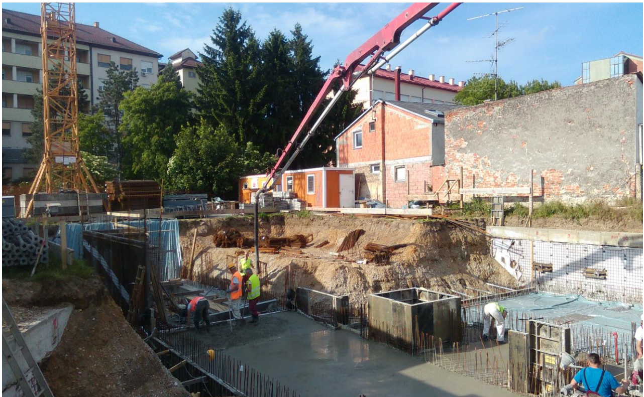
Slika 2. Građevna jama na predmetnoj lokaciji
