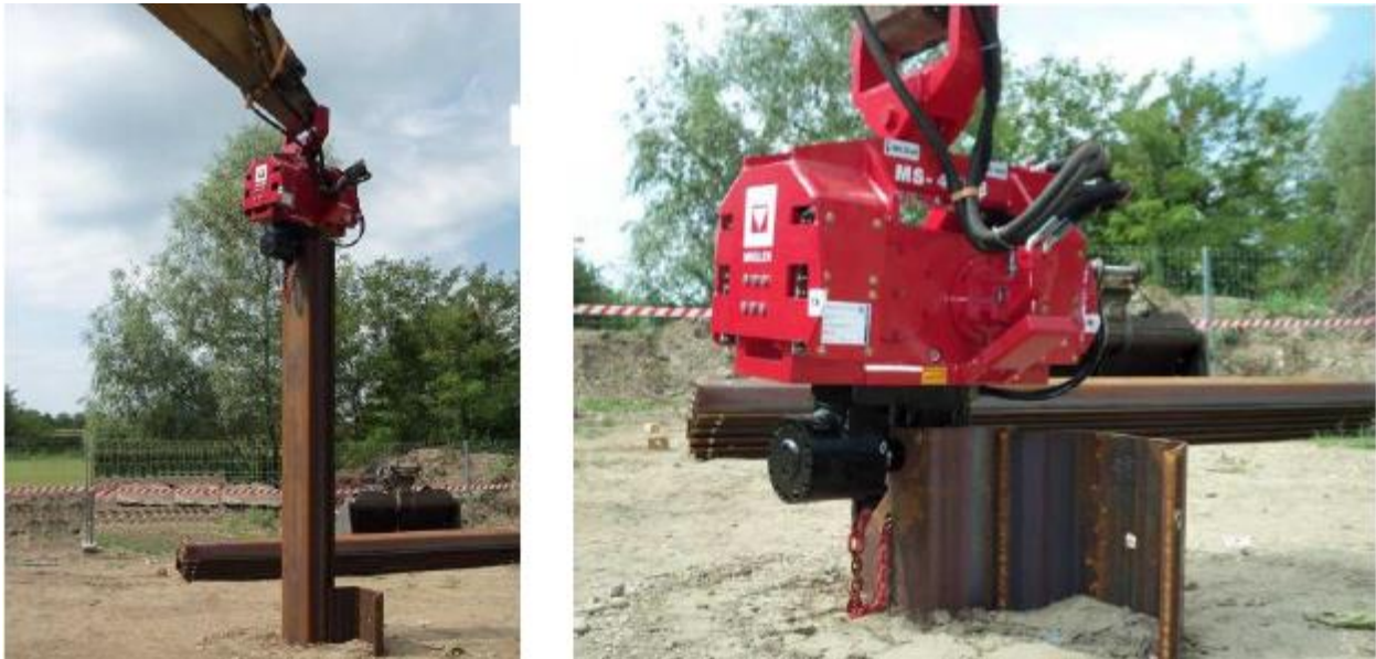
Slika 7. Vibrator za nabijanje i vađenje talpi
