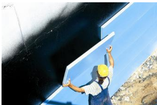
Slika 3.3.4. Ekstrudirani polistiren
