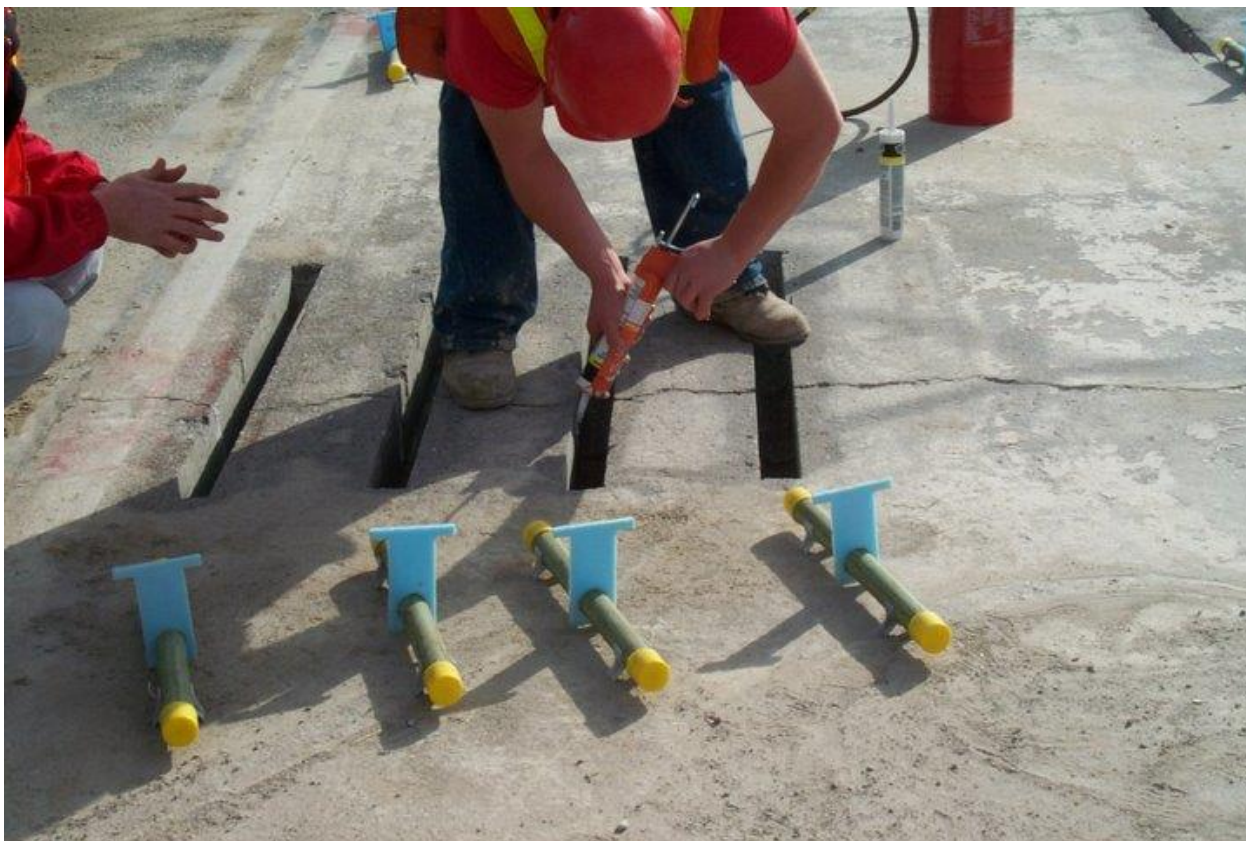
Slika Error! No text of specified style in document..8 Rezanje utora za postavljanje spojnih šipki
