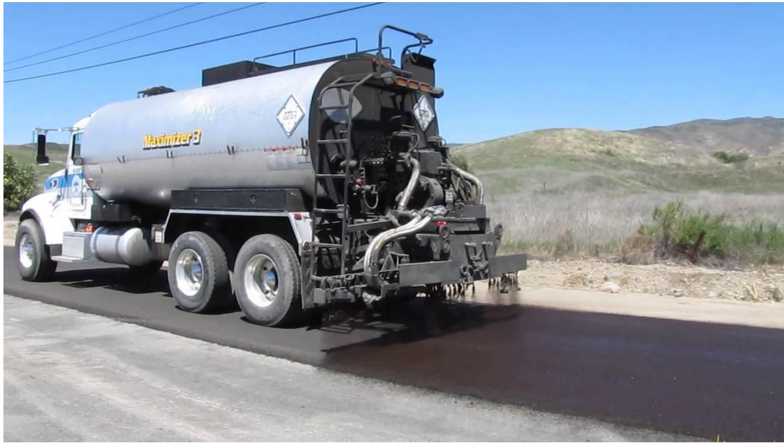
Slika Error! No text of specified style in document..4 Špricanje bitumenom [5]
