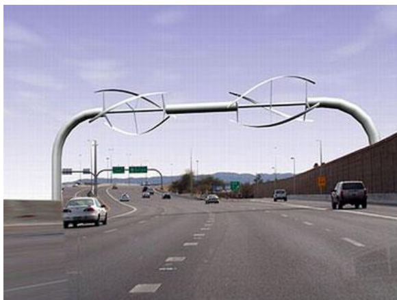
Slika 12. Horizontalna Darrieusova vjetroturbina sa spiralnim lopaticama [21]
