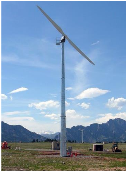
Slika 6. Vjetroturbina s dvije lopatice [16]
