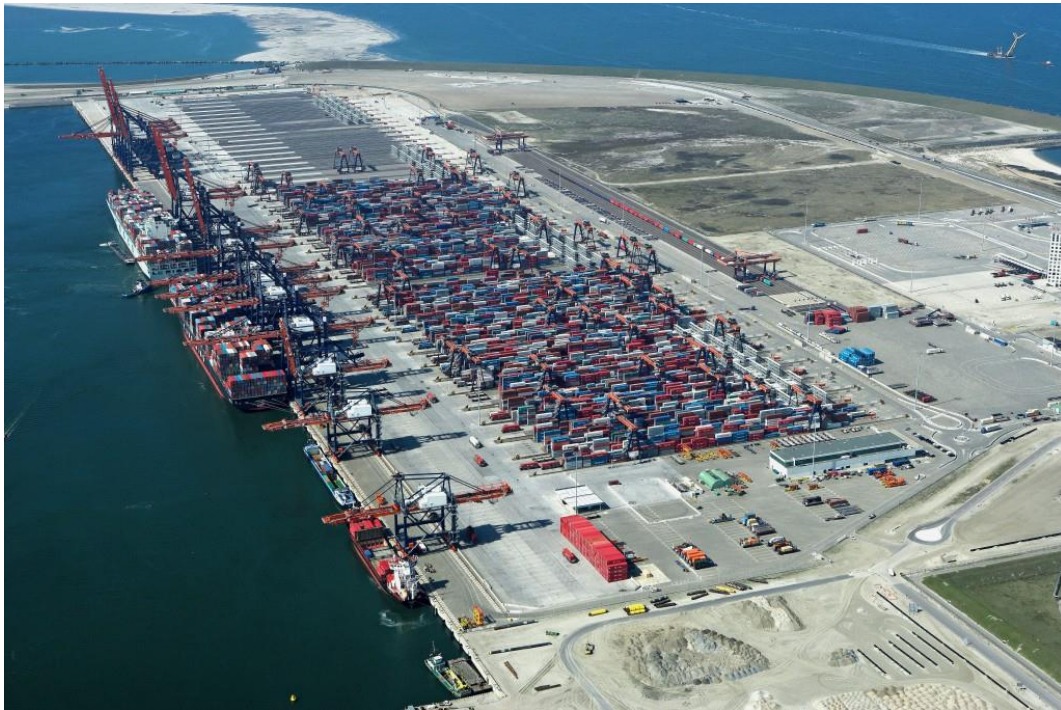
Slika 3.3.:Otvoreno skladište kontejnera u luci Rotterdam, Nizozemska [20]
