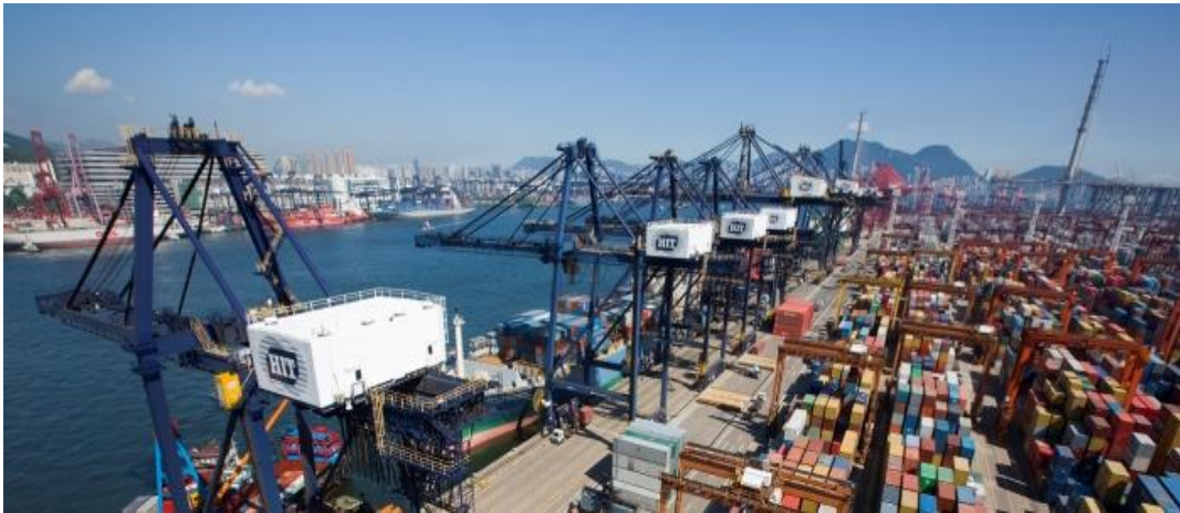
Slika 7.11.:Obalne dizalice i RTG [39]
