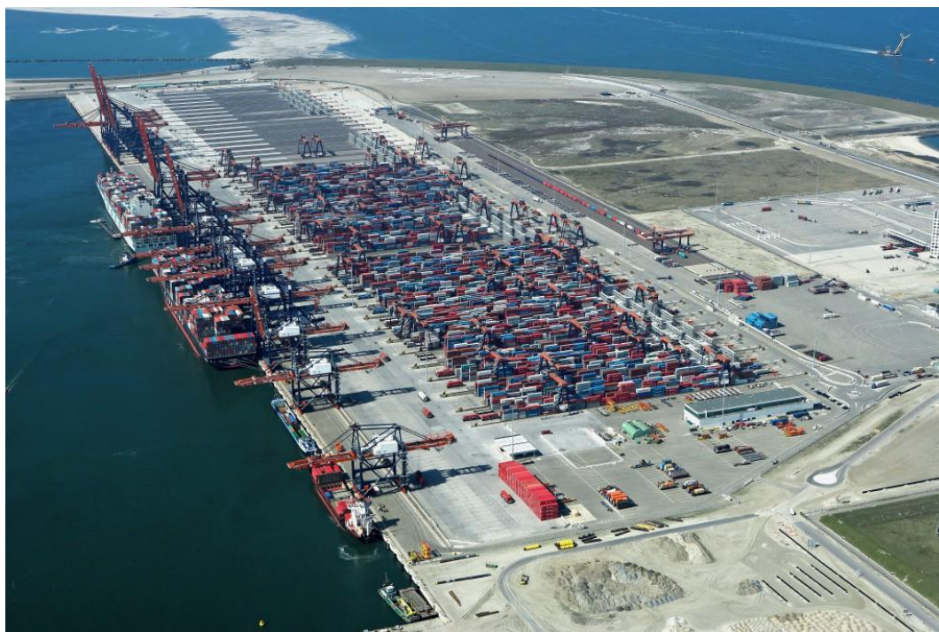
Slika 3.3.:Otvoreno skladište kontejnera u luci Rotterdam, Nizozemska [20]
