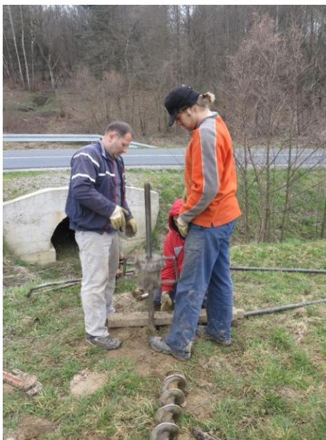
Slika 8.16 Provedba SPP-a na istražnoj bušotini B2
