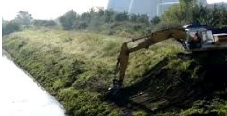
Slika 7.1 Primjeri mehaničkog održavanja otvorenih kanala
