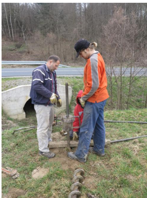
Slika 8.16 Provedba SPP-a na istražnoj bušotini B2
