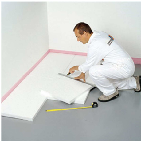
Slika 2.18 Pod izoliran EPS pločama
