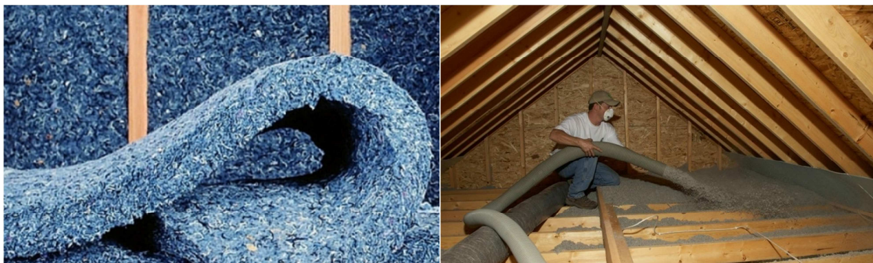
Slika 2.8 Pamuk izolacija u roli i ugradnja u rastresitom stanju
