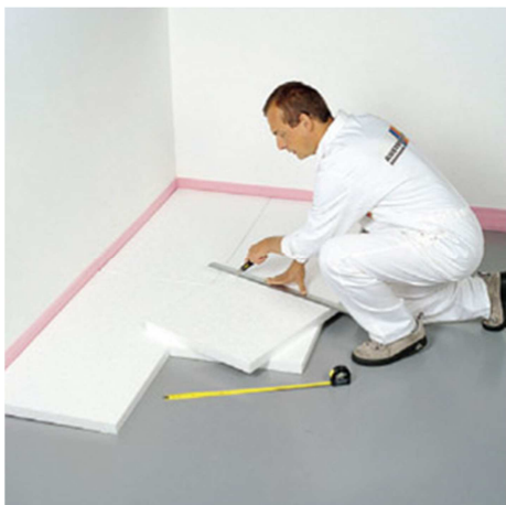
Slika 2.18 Pod izoliran EPS pločama
