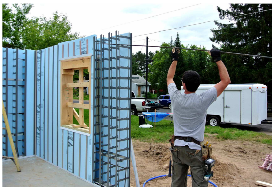
Slika 2.4 Oplata za zidove i stropove od XPS-a
