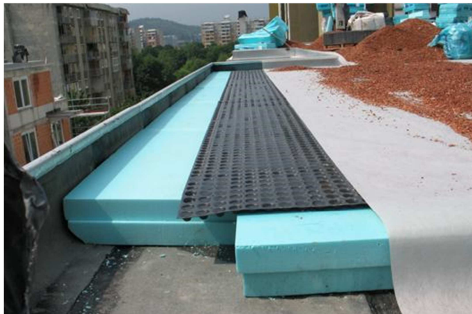
Slika 2.19 Ravni krov izoliran XPS pločama
