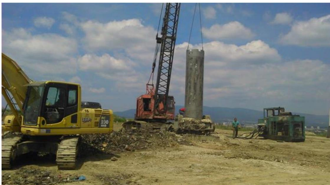
Slika 2.6 Bušenje plinskih zdenaca (Videc, Z. 2015.)
