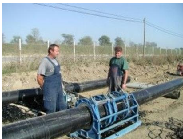
Slika 2.5 Radovi na izvedbi sustava odvodnje procjednih voda ( http://his.hr , 2016.)
