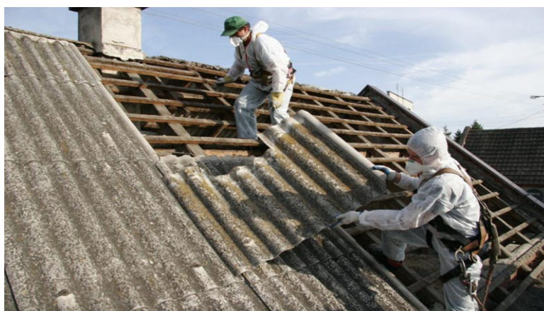
Slika 2.5. Pravilno skidanje salonit ploča sa krova(Izvor:www.ipress.rtl.hr, preuzeto 04.09.2016.)
