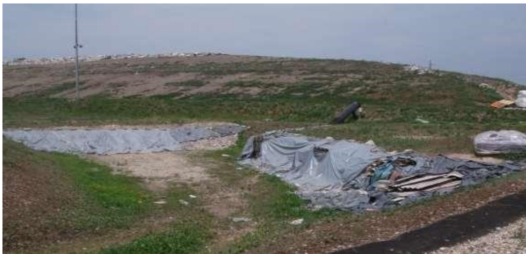
Slika 3.1. Izgrađena ploha za odlaganje građevinskog otpada koji sadrži azbest u Totovcu (Izvor: M. Marković-Zbrinjavanje građevnog otpada, preuzeto 05.09.2016.)
