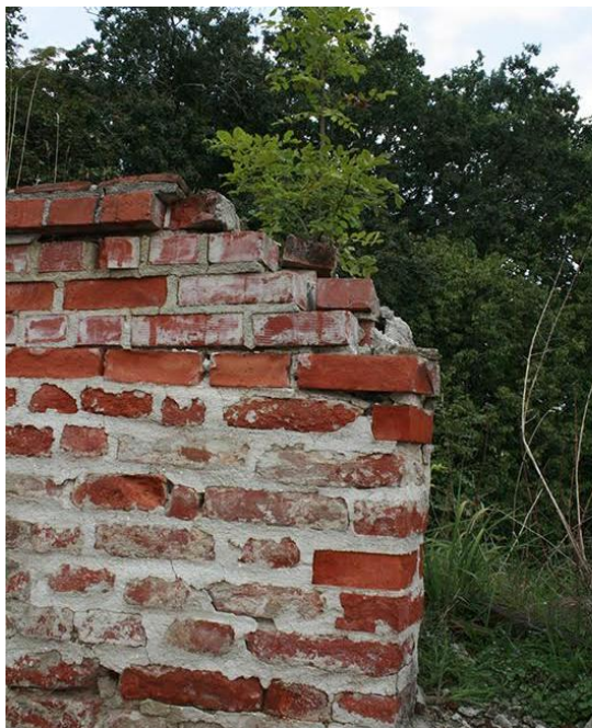
Slika 4.4. Oštećenje grudobrana SZ bastiona
