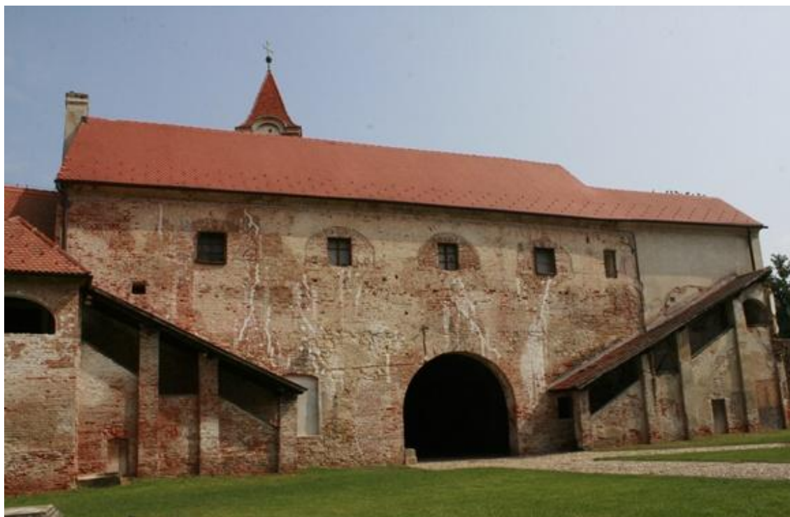
Slika 4.14. Dvorišna fasada ulaznog bastiona
