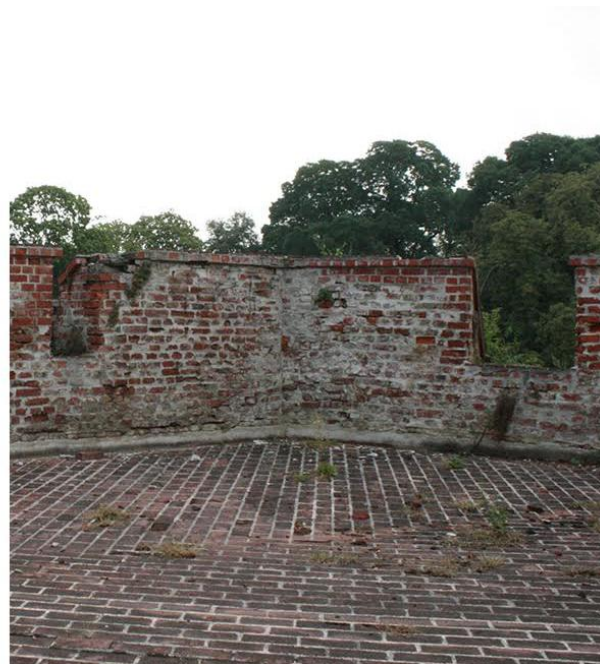
Slika 4.4. Oštećenje grudobrana SZ bastiona
