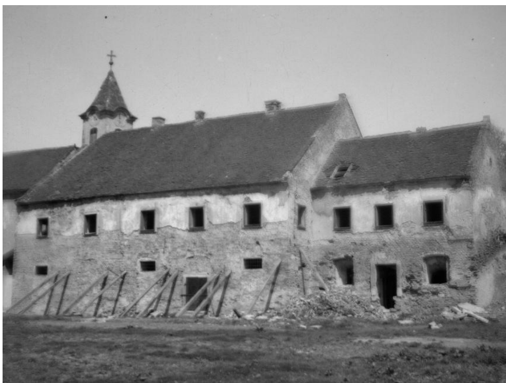
Slika 3.12. Srušena građevina iz 18.st.
