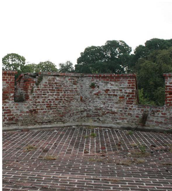
Slika 4.4. Oštećenje grudobrana SZ bastiona
