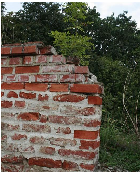
Slika 4.4. Oštećenje grudobrana SZ bastiona
