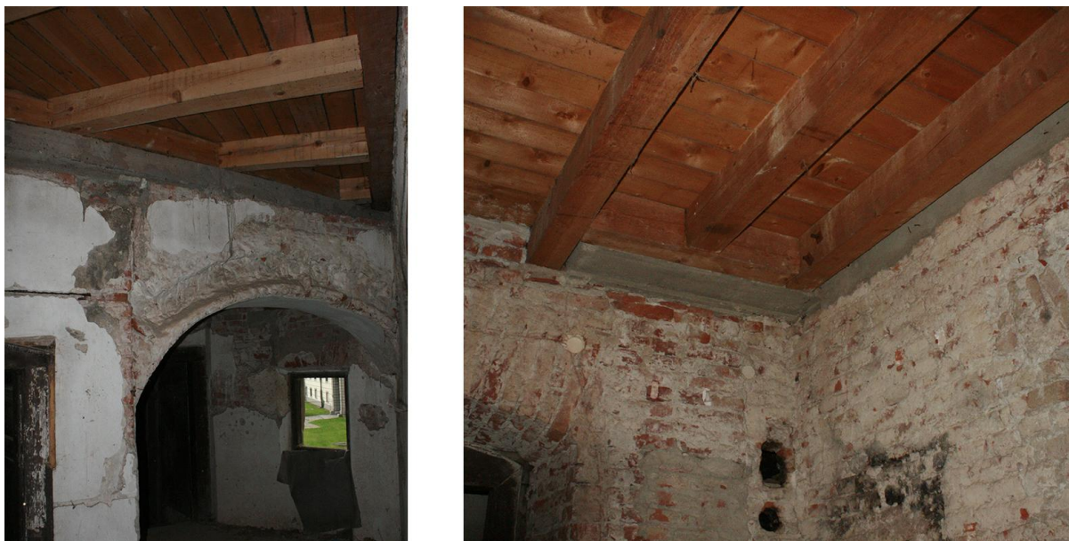
Slika 3.6. Ojačanje postojećih zidova I. kata
