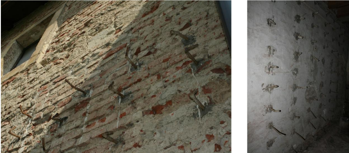
Slika 3.7. Injektiranje zida u prizemlju i katu
