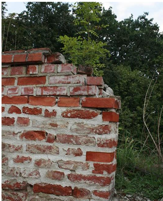
Slika 4.4. Oštećenje grudobrana SZ bastiona
