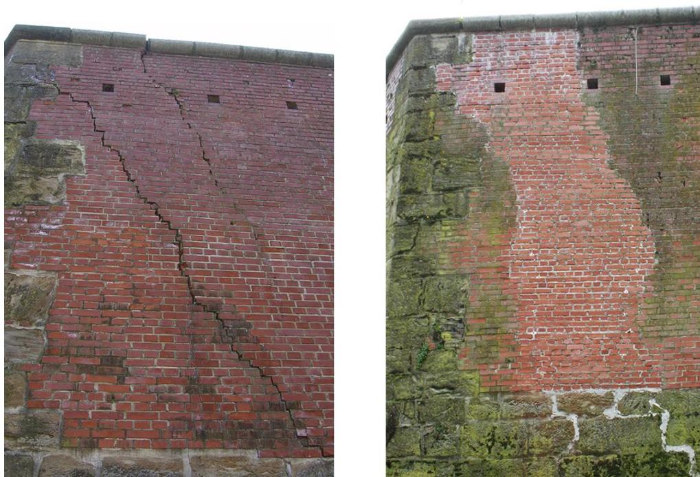
Slika 4.21. Sanacija zida bastiona, 2006. godine
