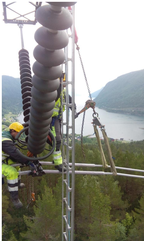
Slika 4.15. Pričvršćivanje faznih vodiča na nosivom stupu
