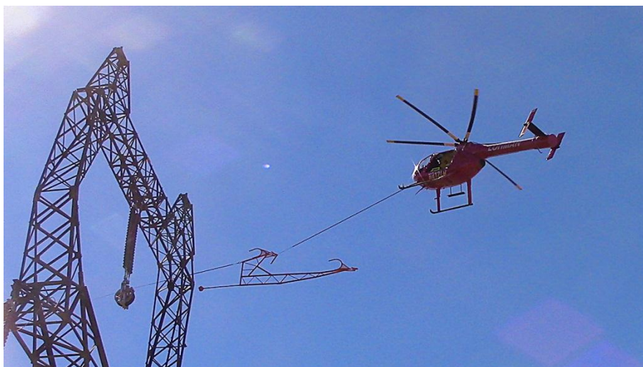
Slika 4.4. Razvlačenje užeta za srednju fazu
