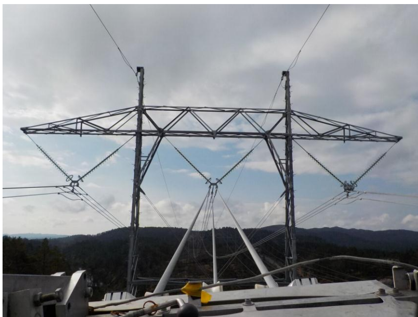
Slika 4.2. Nosivi stup s V izolatorskim lancima
