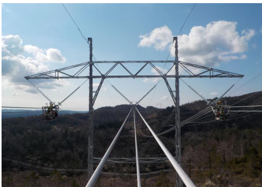
Slika 4.23. Postavljanje međufaznih odstojnika
