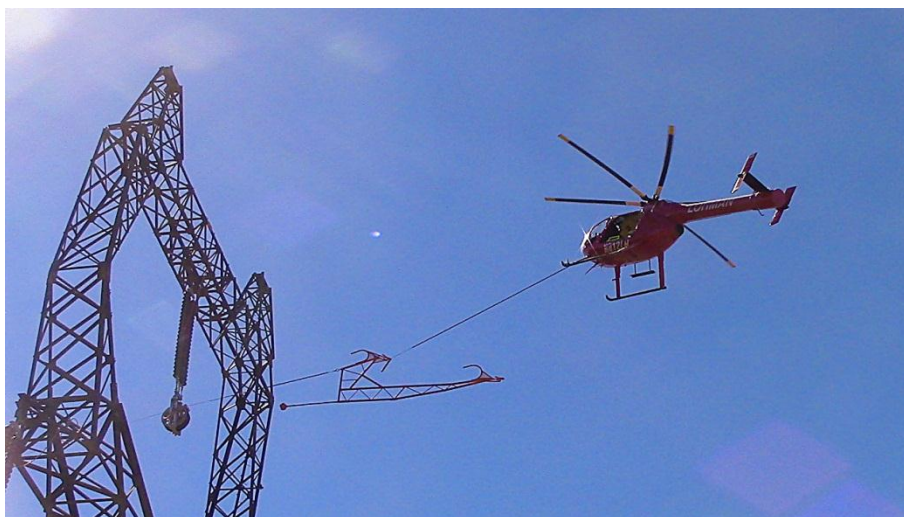
Slika 4.4. Razvlačenje užeta za srednju fazu
