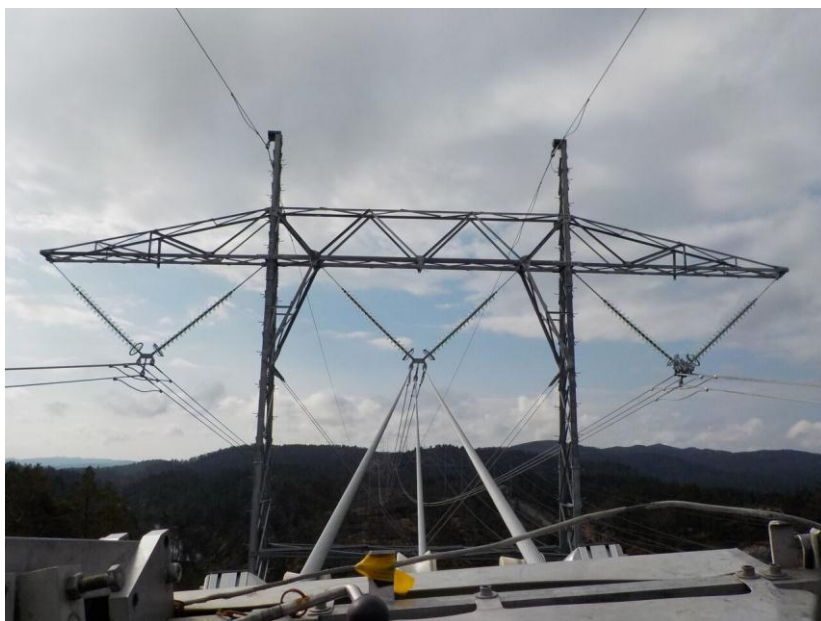
Slika 4.2. Nosivi stup s V izolatorskim lancima
