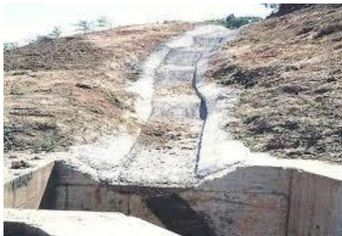
Slika 3.7: Kaskadno izeveden jarak
