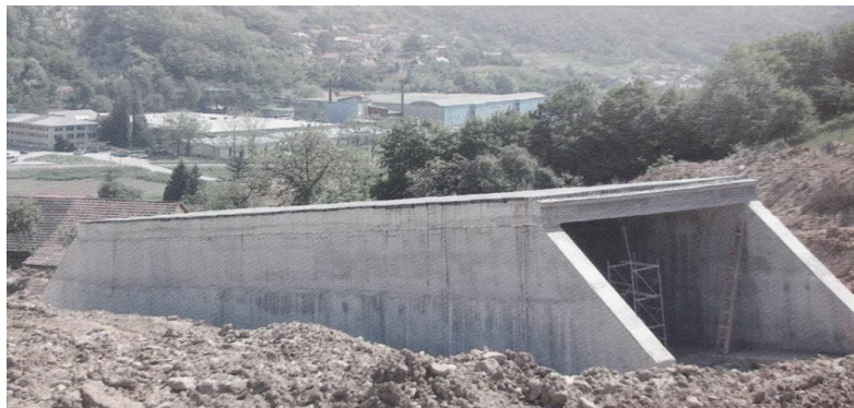
Slika 3.4: Gradnja pločastog propusta
