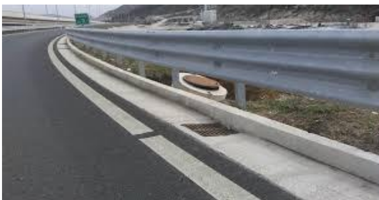
Slika 3.13: Betonski trokutasti rigol izveden kontinuirano
