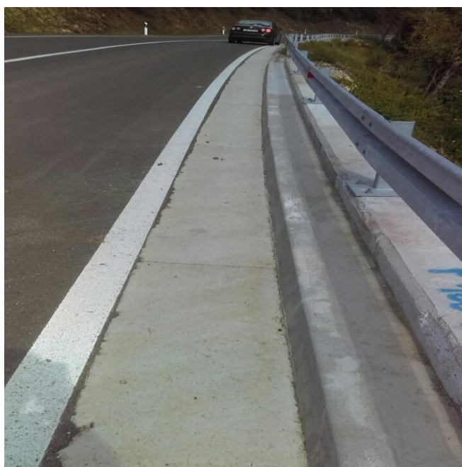
Slika 8.30: Sustav odvodnje površinskih voda (rigol s rubnjakom)
