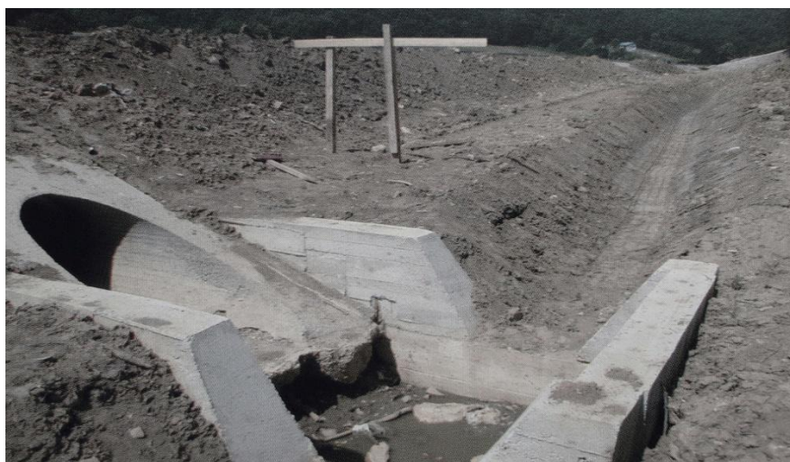
Slika 5.45: Uljevna glava propusta
