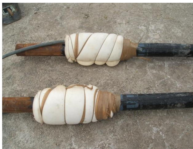
Slika 8.28: Brtva sa spojem čelične i okiten cijevi
