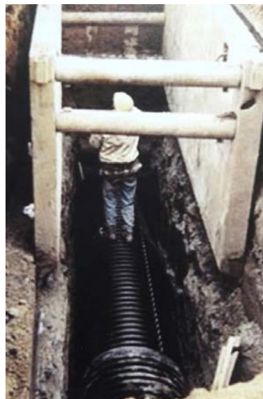
Slika 3.27: Podgrada rova
