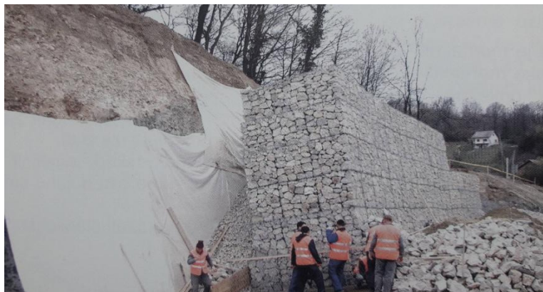
Slika 4.18: Izgradnja zida od gabiona
