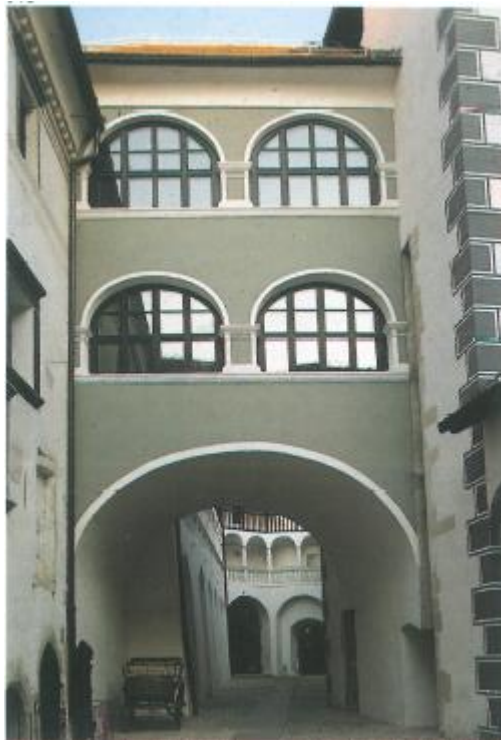
Slika 3.50 Most između gotičke kule i sjevernih zidina
