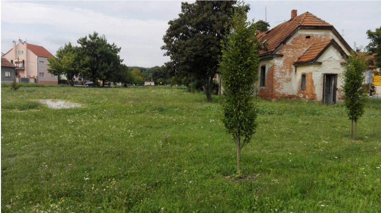
Slika 10 Ruševna zgrada na parceli
