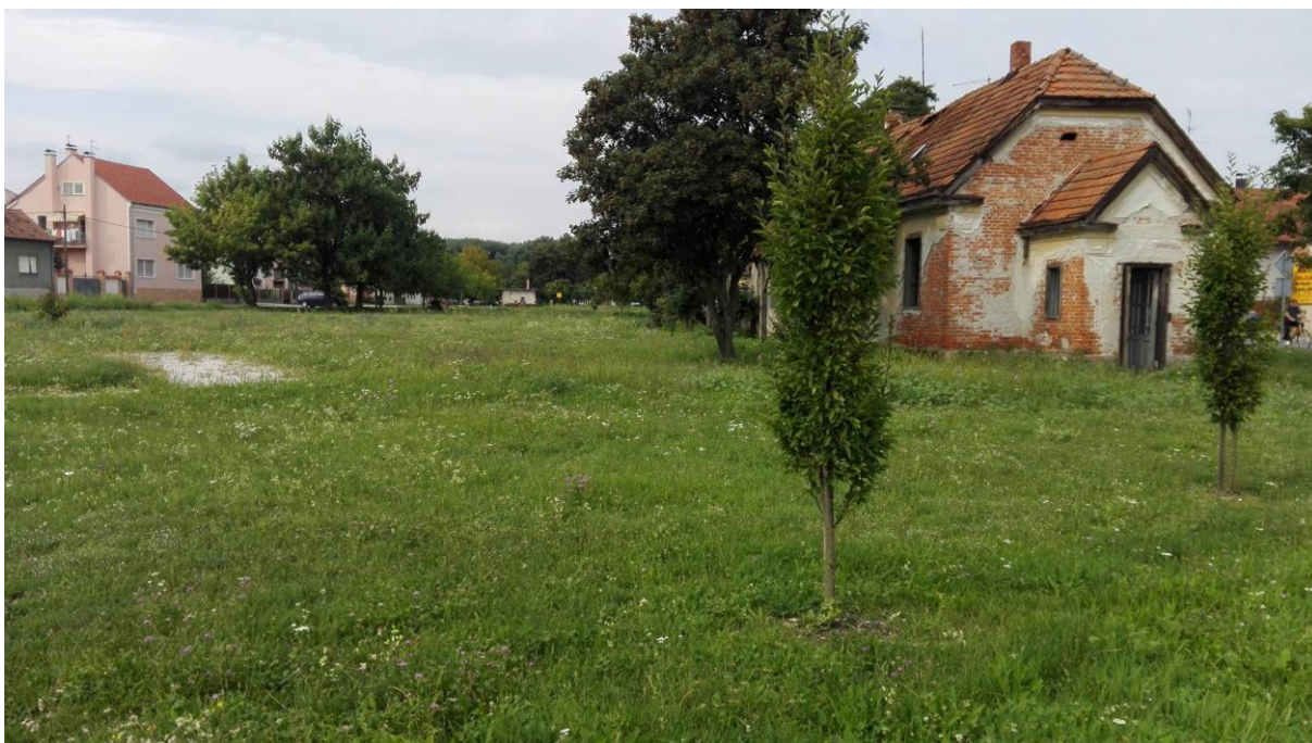
Slika 10 Ruševna zgrada na parceli
