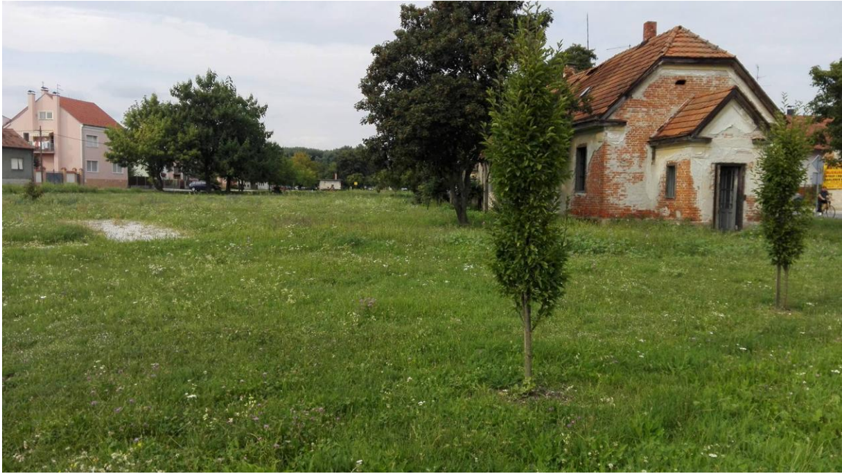
Slika 10 Ruševna zgrada na parceli
