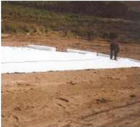
Slika 6.1.2. Postavljanje geotekstila (Izvor: http://www.buic-bas.hr/materijali/7/geotekstili/ )
