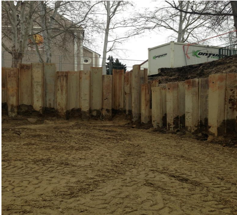
Slika 23. Građevinska jama nakon uređenih drenova
