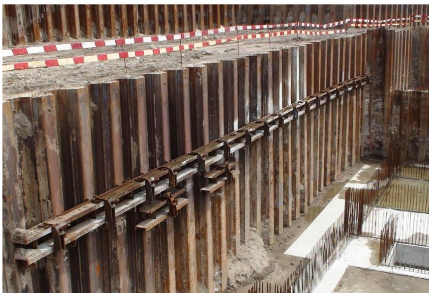
Slika 5. Zaštita građevinske jame žmurjem.
