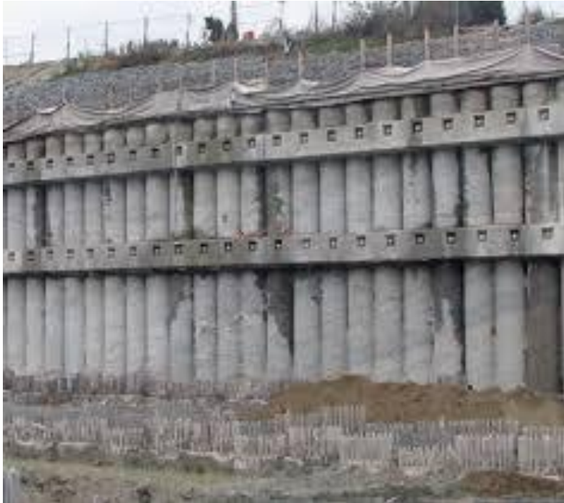
Slika 8. Armirano betonski piloti.
