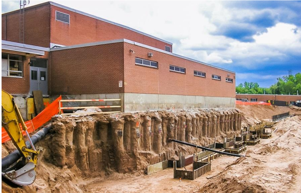
Slika 7. Izgled građevinske jame nakon metode mlaznog injektiranja.
