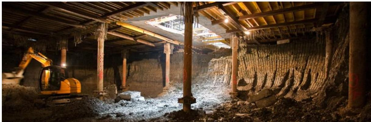
*Slika 4. Iskop rova metodom „TOP DOWN“*
