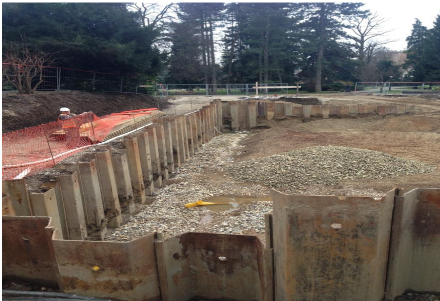
Slika 23 b)Zatrpavanje građevinske jame batudom
