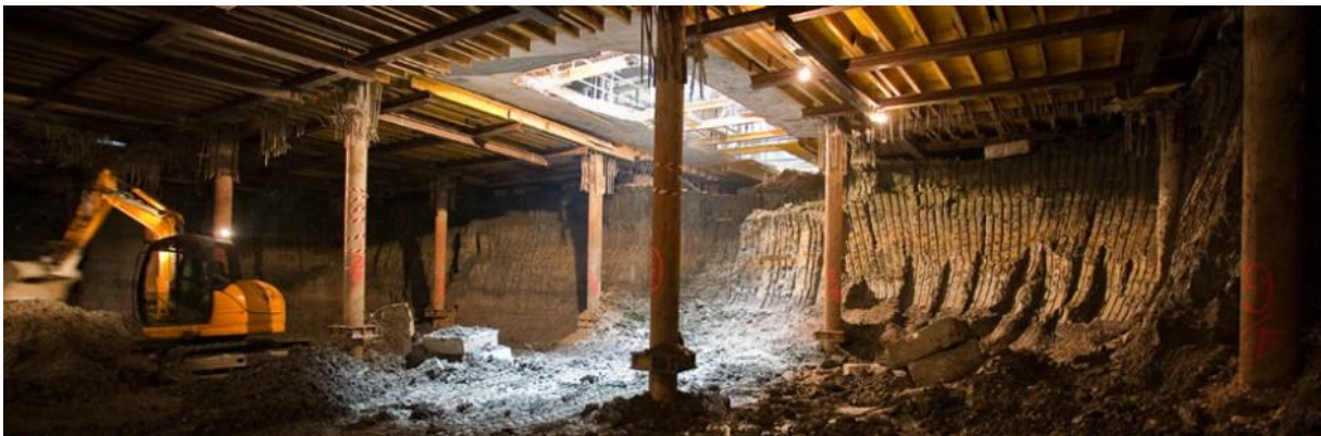
Slika 4. Iskop rova metodom „TOP DOWN“
