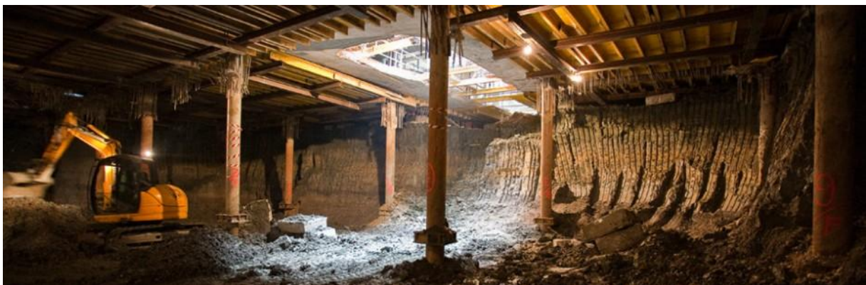
Slika 4. Iskop rova metodom „TOP DOWN“
