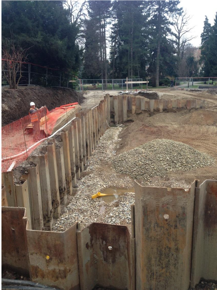
Slika 21. Zatrpavanje građevinske jame batudom.
