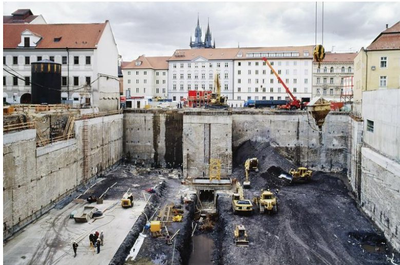
Slika 3. Prikaz dijafragma u građevinskoj jami.
