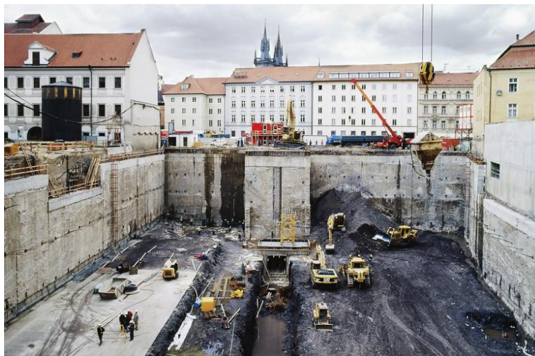
Slika 3. Prikaz dijafragma u građevinskoj jami.
