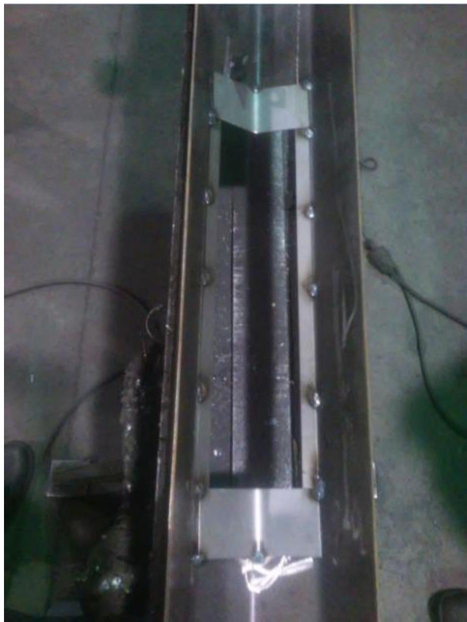
*Slika 5.10. Ugradnja elemenata revizionog otvora*
