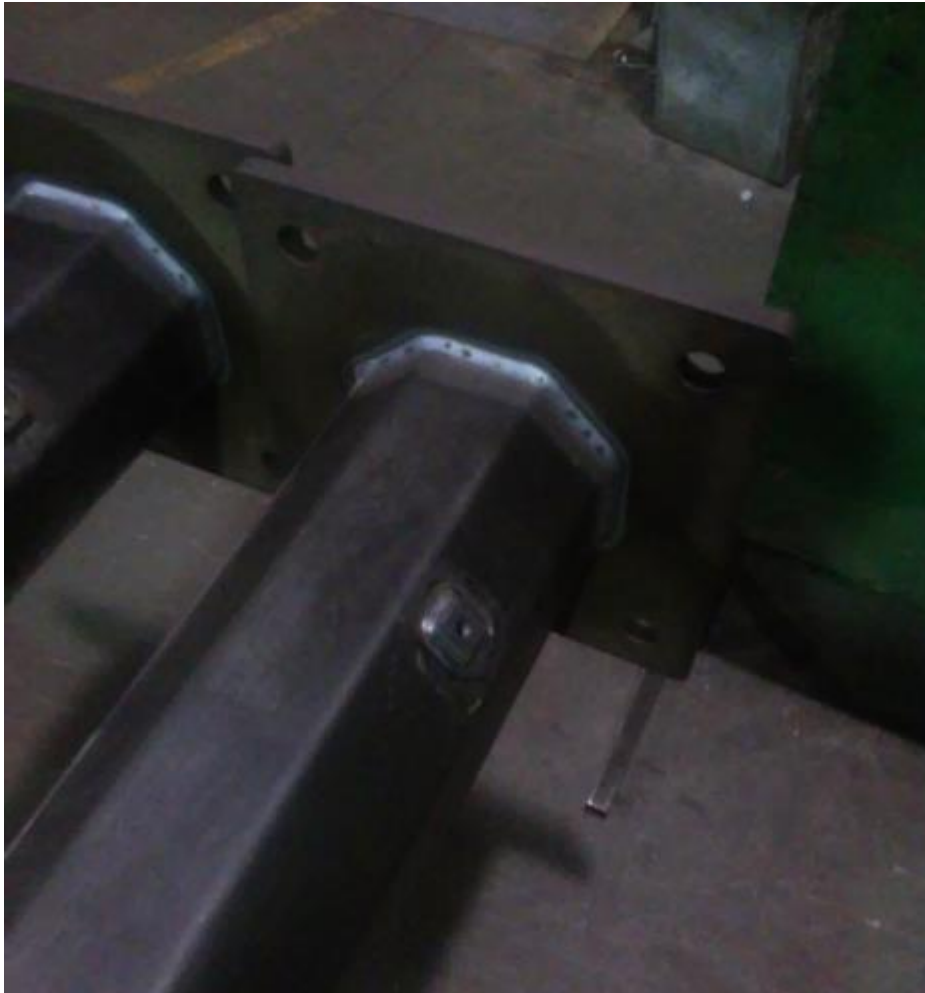
Slika 5.14. Ugradnja i zavarivanje temeljne ploče
