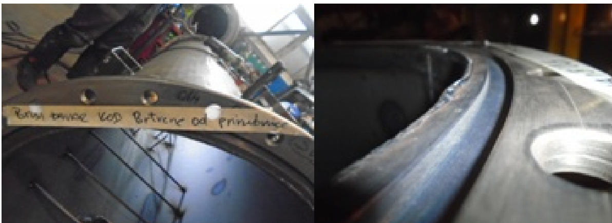
Slika 4.6. Primjer nedopuštenog izgleda zavora u dodiru sa brtvenom površinom
