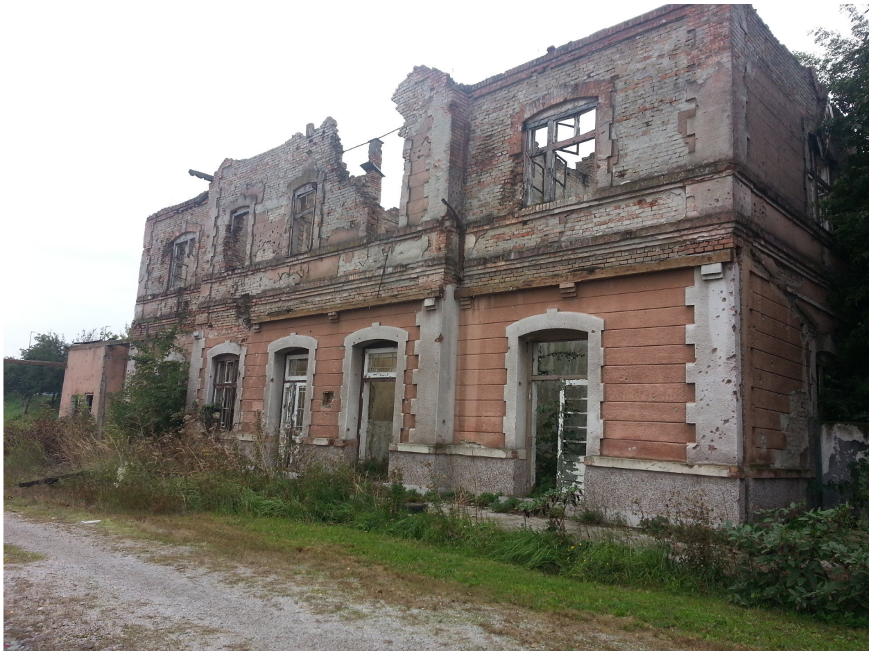
Slika 3.11-1 Kolodvorska zgrada željezničkog kolodvora Vukovar (izvor: arhiva ŽPD d.d.)
