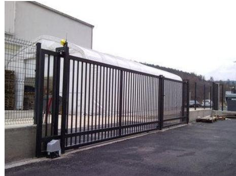
*Slika 2.3. Klizna dvorišna vrata s vodilicom [3]*
