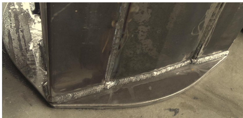
Slika 4.17: Vizualna kontrola zavara
