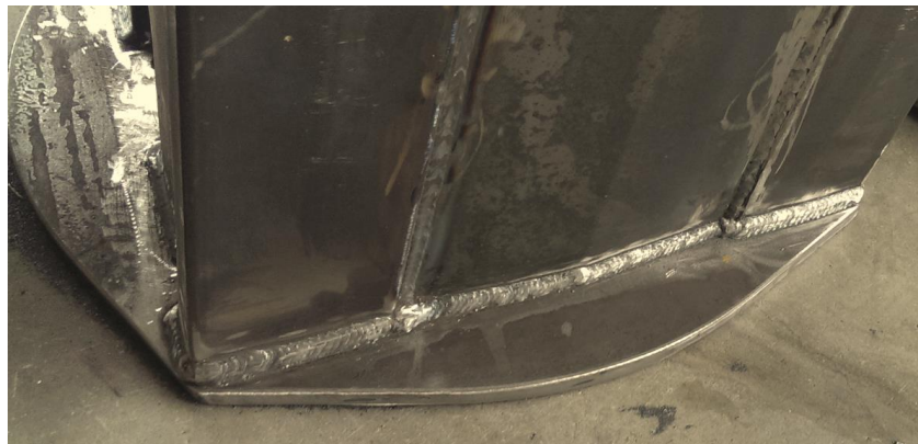
Slika 4.17: Vizualna kontrola zavara
