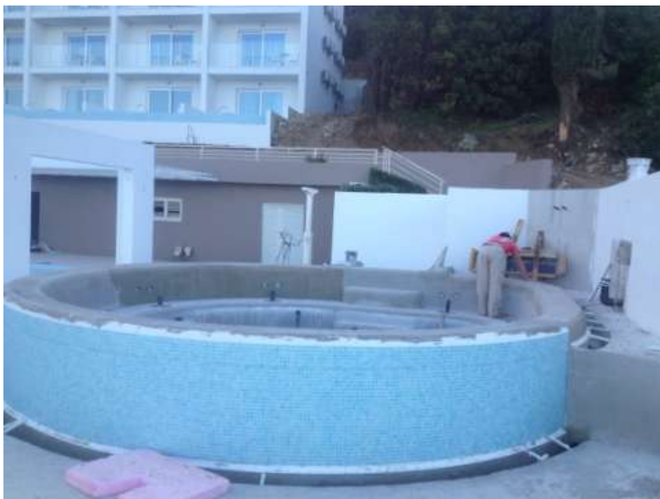
Slika 6.2.5.: postavljanje mozaika na vanjskom bazenu hotela Nimfe
