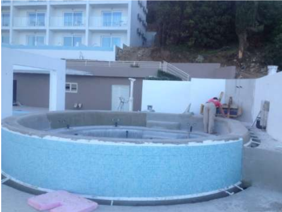
Slika 6.2.5.: postavljanje mozaika na vanjskom bazenu hotela Nimfe
