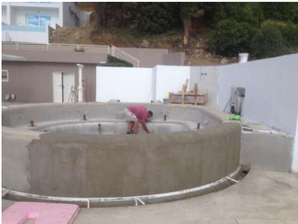
slika 6.2.4.: Postavljanje hidroizolacije na vanjskom bazenu hotela Nimfe
