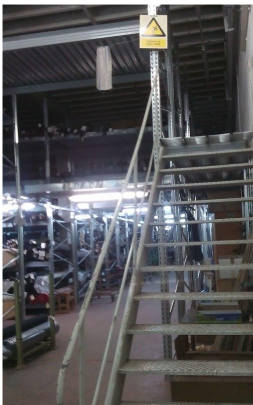
Slika 18. Stube za pristup podestu
