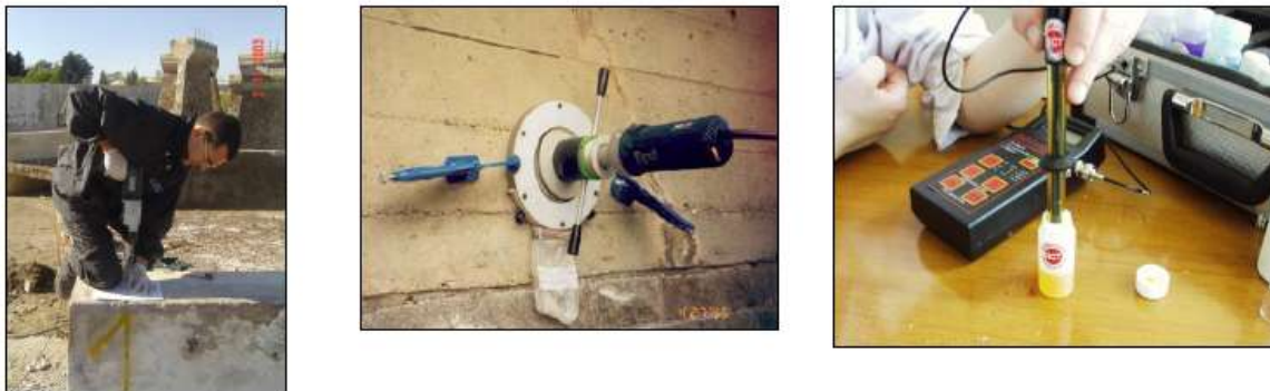
Slika 6.1. Postupak uzimanja praha betona za određivanja sadržaja klorida u betonu
