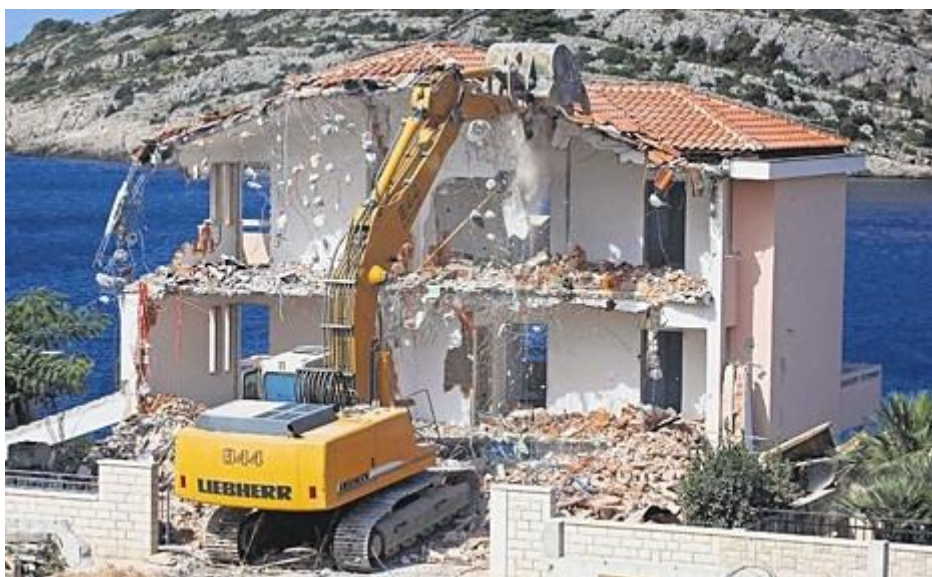
Slika 17. Rušenje klasične kuće od cigle i betona
