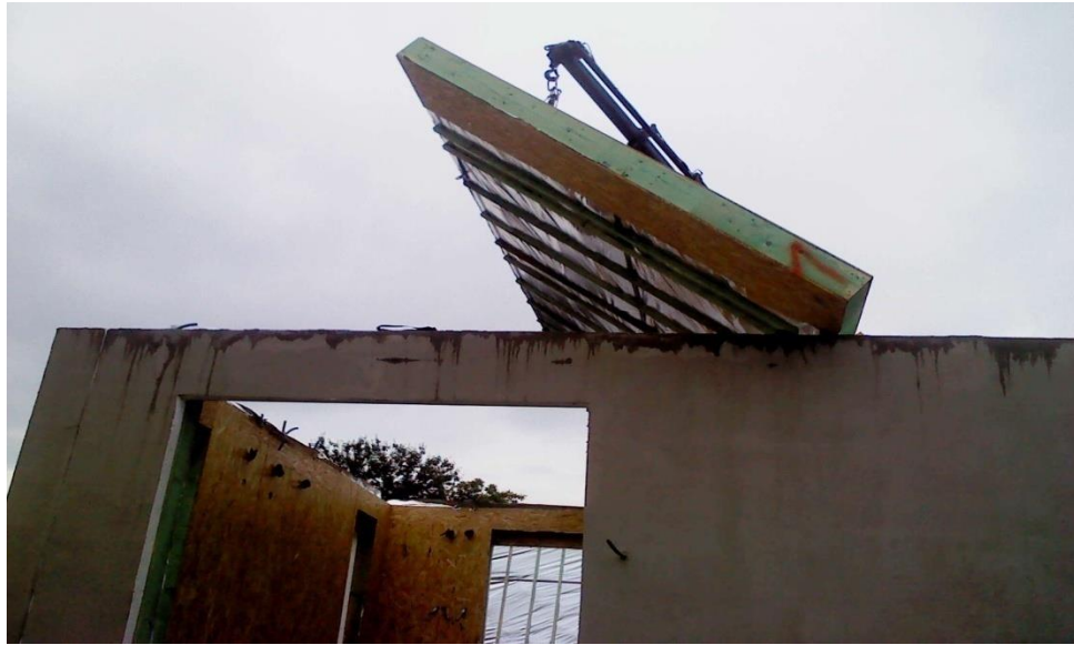
Slika 39. Montaža pomoću dizalice
