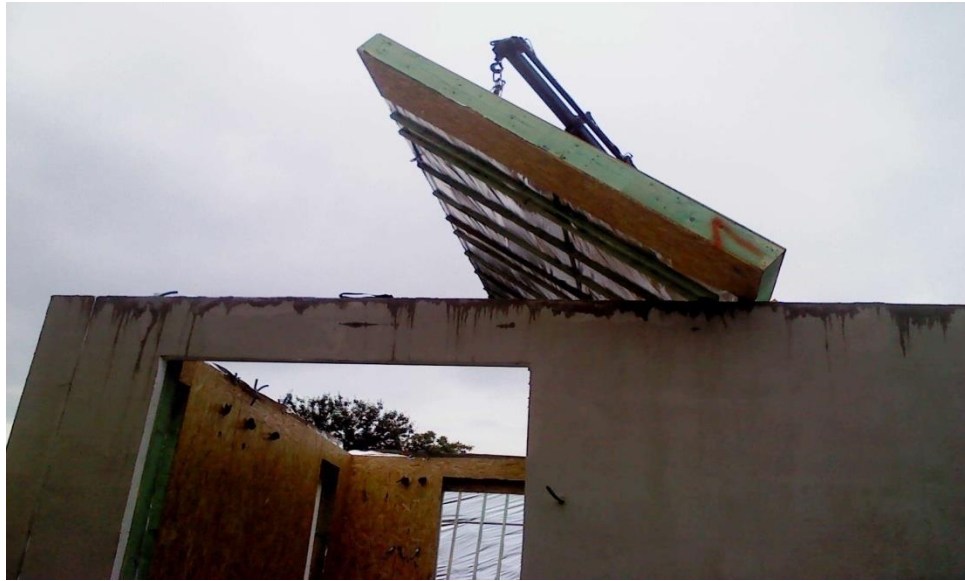
Slika 39. Montaža pomoću dizalice
