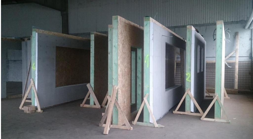
Slika 36. Gotovi zidovi spremni za utovar na kamion
