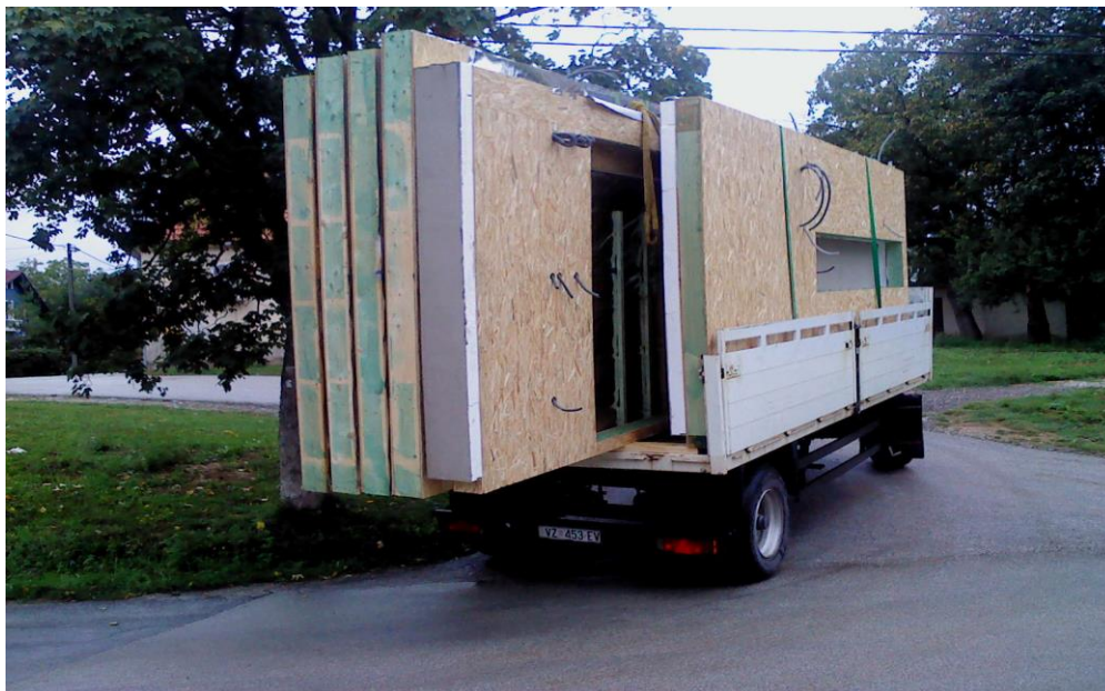
Slika 7. Dovoz gotovih zidova
