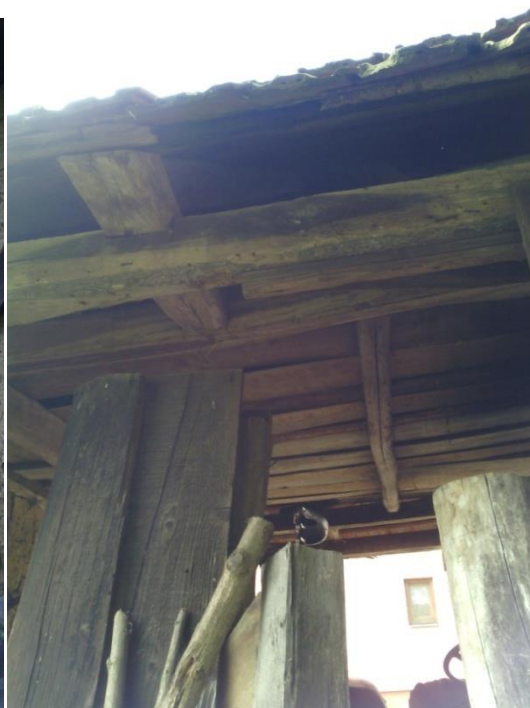
Slika 2. Strop stare zagorske kuće
