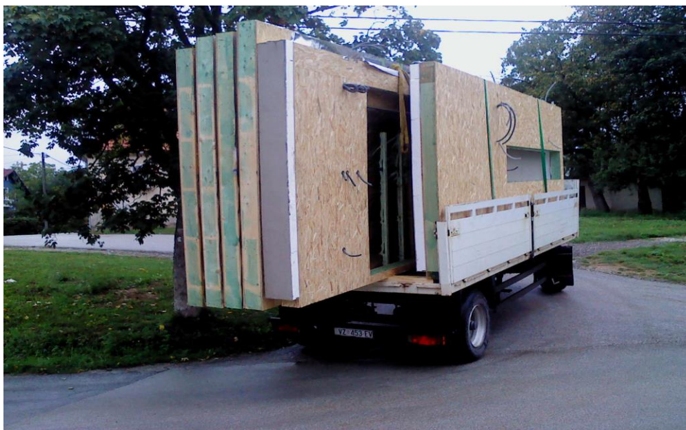
Slika 7. Dovoz gotovih zidova
