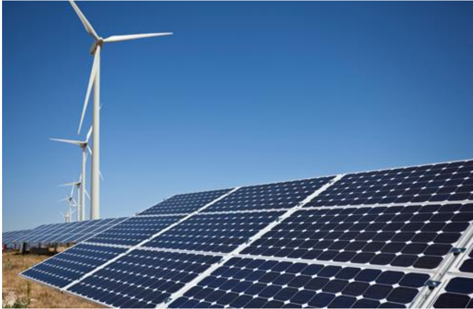
Slika 3.3.2. Vjetrogeneratori i fotonaponski paneli
