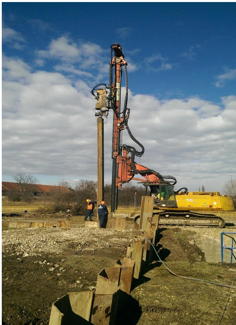
*Slika 46. Ugradnja žmurja vibronabijačem*
