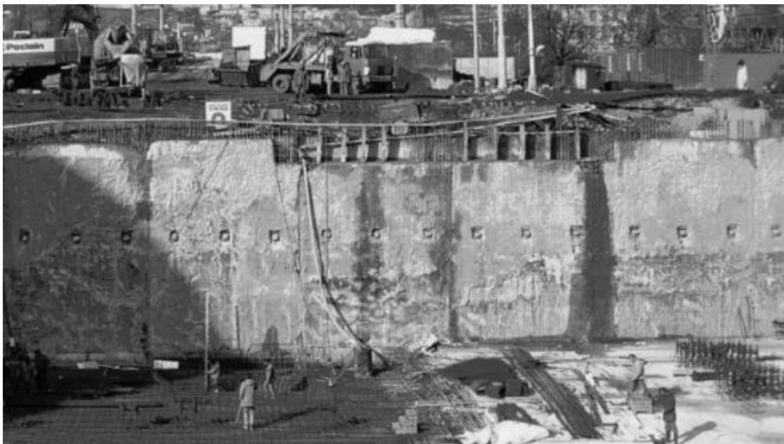
Slika 10. Armiranobetonska dijafragma
