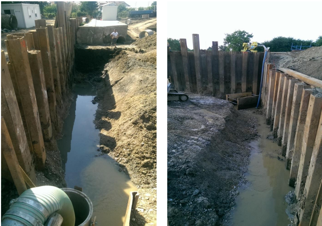
Slika 49. Voda u građevinskoj jami KP-II
