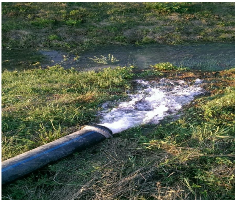
Slika 51. Odvođenje vode u odvodni kanal
