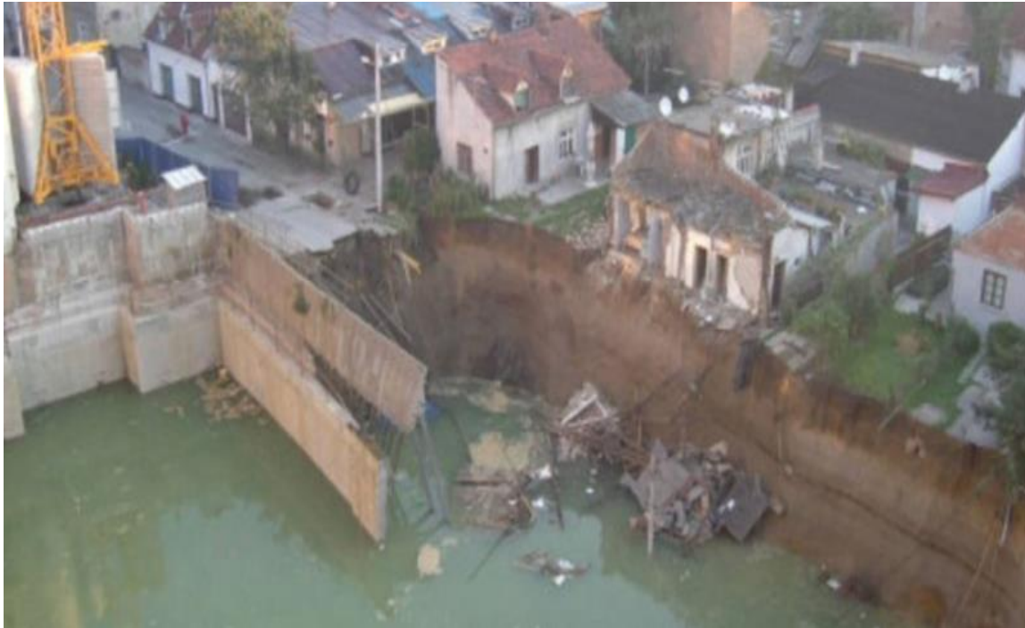
Slika 15. Posljedice hidrauličkog sloma tla u Kupskoj ulici
