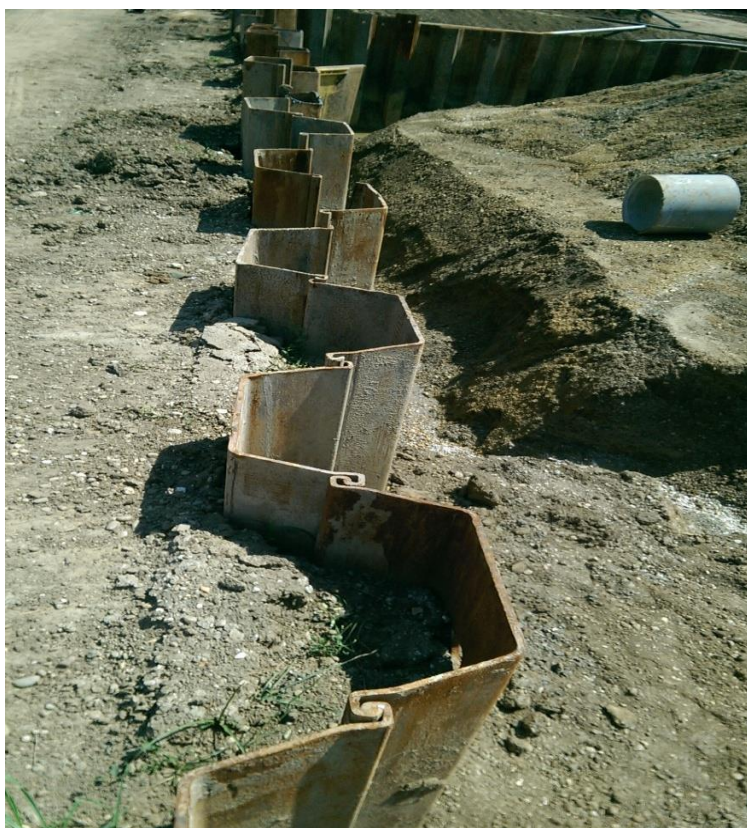
Slika 45. Postavljanje žmurja kontinuirano, jedan panel do drugog
