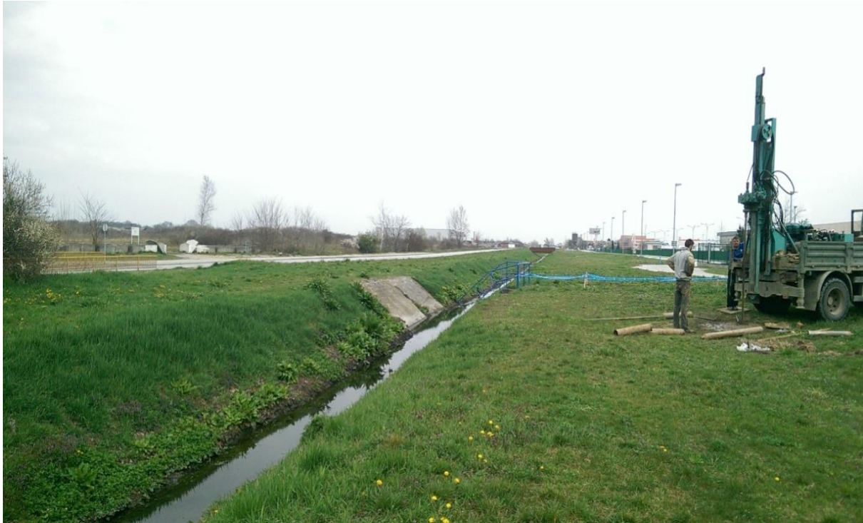
Slika 31. Lokacija kišnog preljeva KP-I
