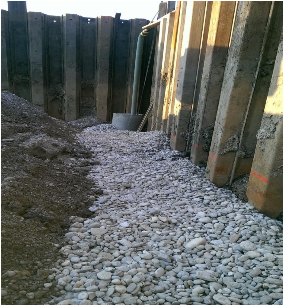
Slika 52. Zatvaranje rova batudom
