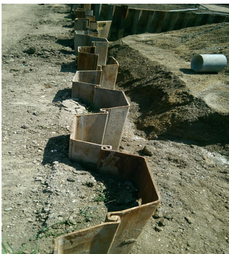
Slika 45. Postavljanje žmurja kontinuirano, jedan panel do drugog
