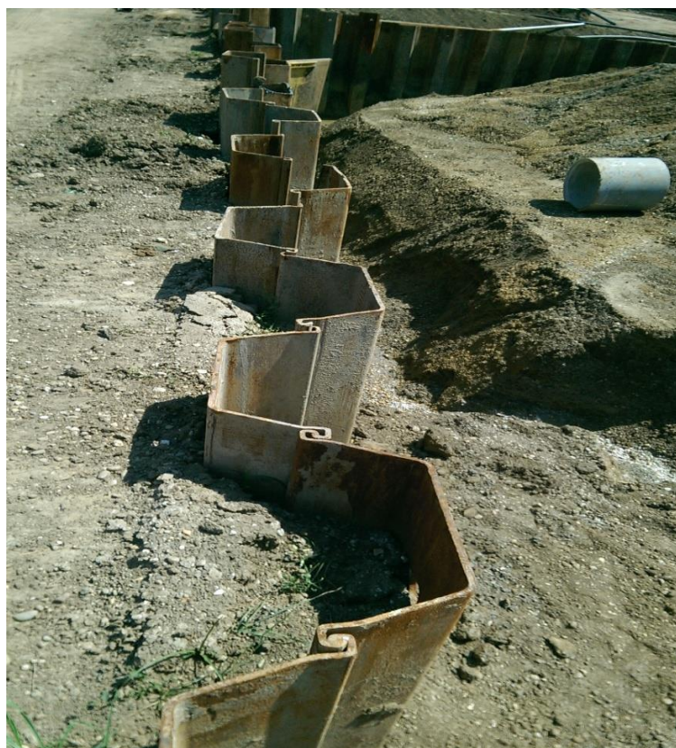
Slika 45. Postavljanje žmurja kontinuirano, jedan panel do drugog
