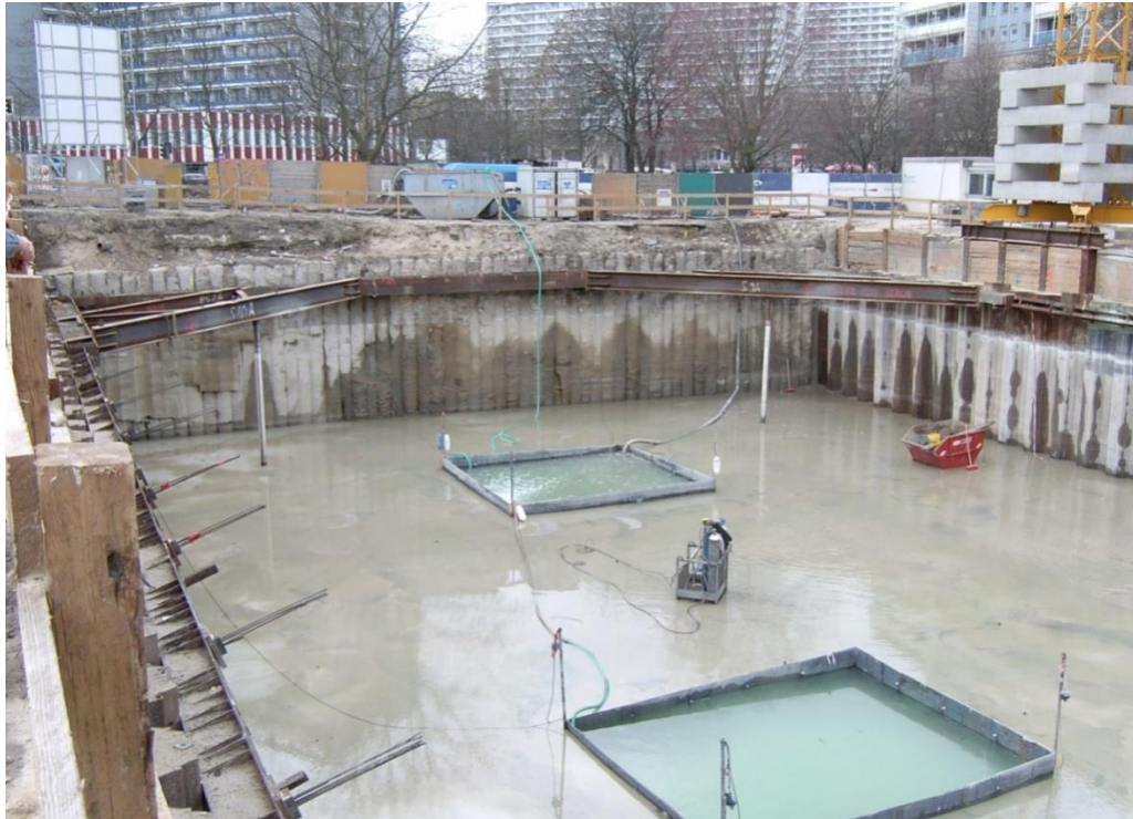
Slika 13. Voda u građevinskoj jami
