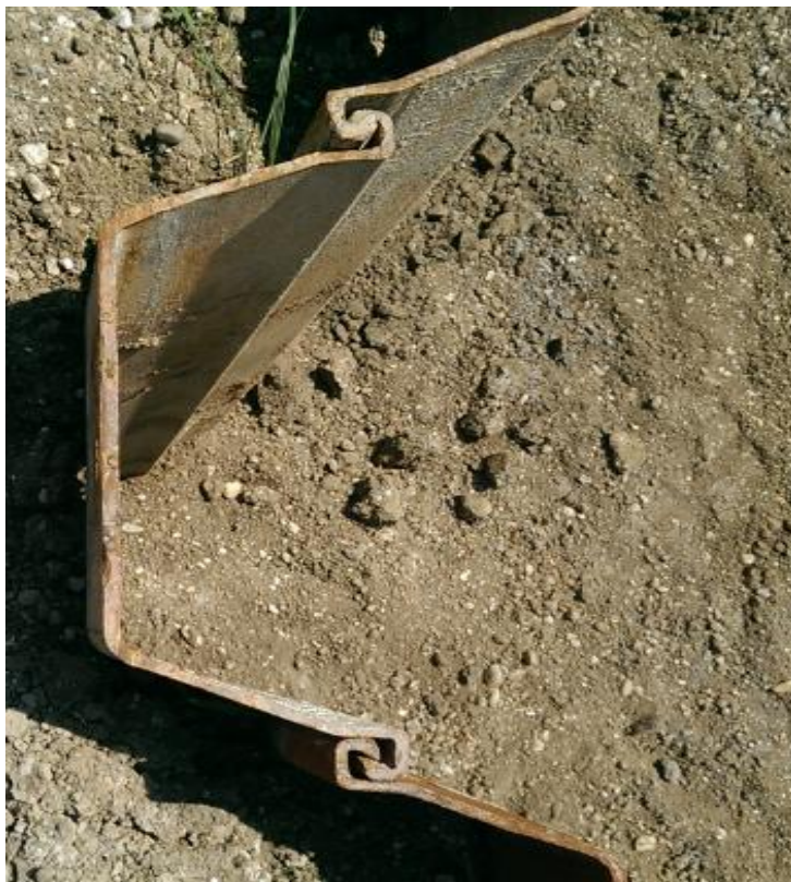
Slika 44. Način spajanja žmurja
