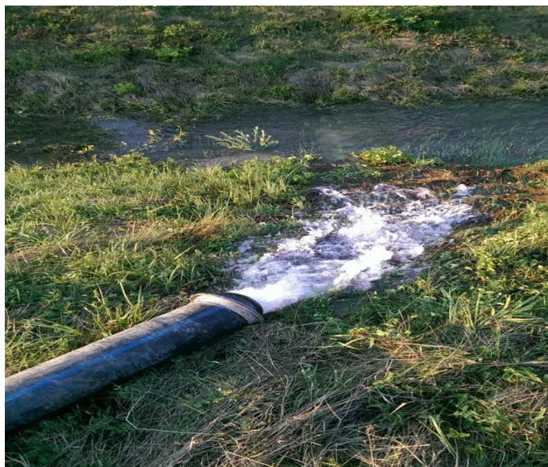
Slika 51. Odvođenje vode u odvodni kanal
